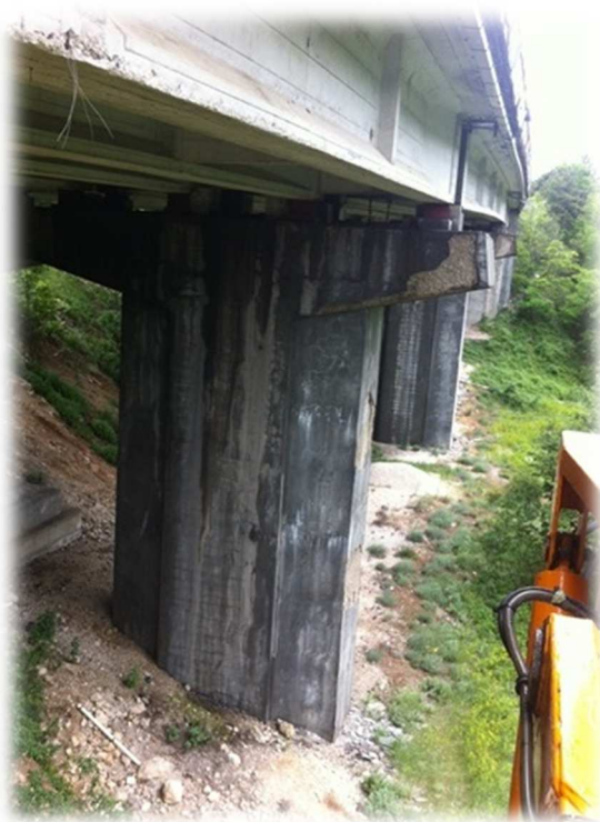
Figura 6 – Pila viadotto tipica e stato di ammaloramento di una pila
