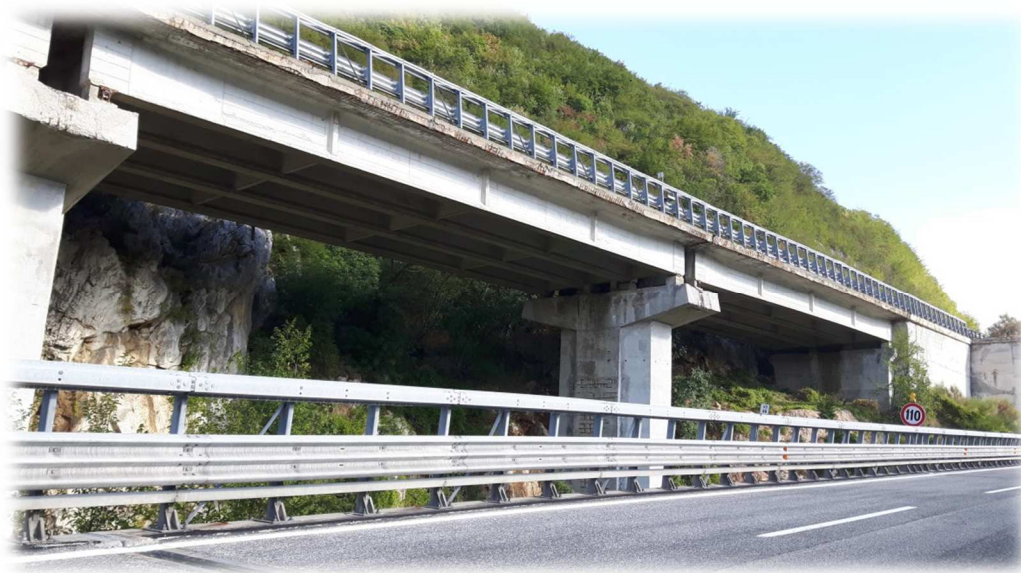
Figura 3 – Immagine del viadotto Le Pastena – Stato attuale
