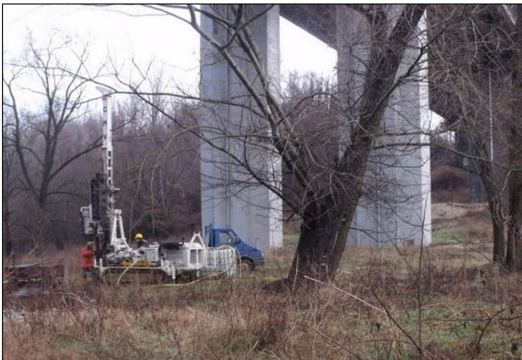
Postazione sulla verticale del sondaggio VI074_S2_DH Fornaca
