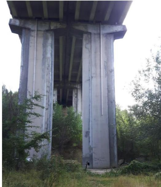
Figura 2: Sistema di drenaggio esistente
