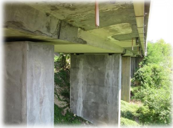
Viadotto Valle Monito
