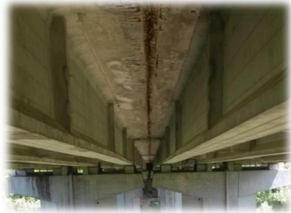
Viadotto Valle Orsara
