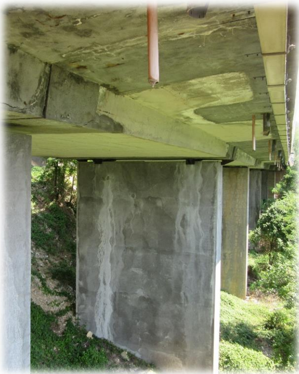
Viadotto Valle Monito
