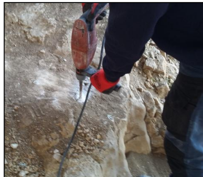
Fasi di ancoraggio
