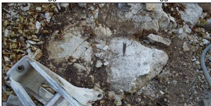
Particolare 1 - rottua della roccia su perno
