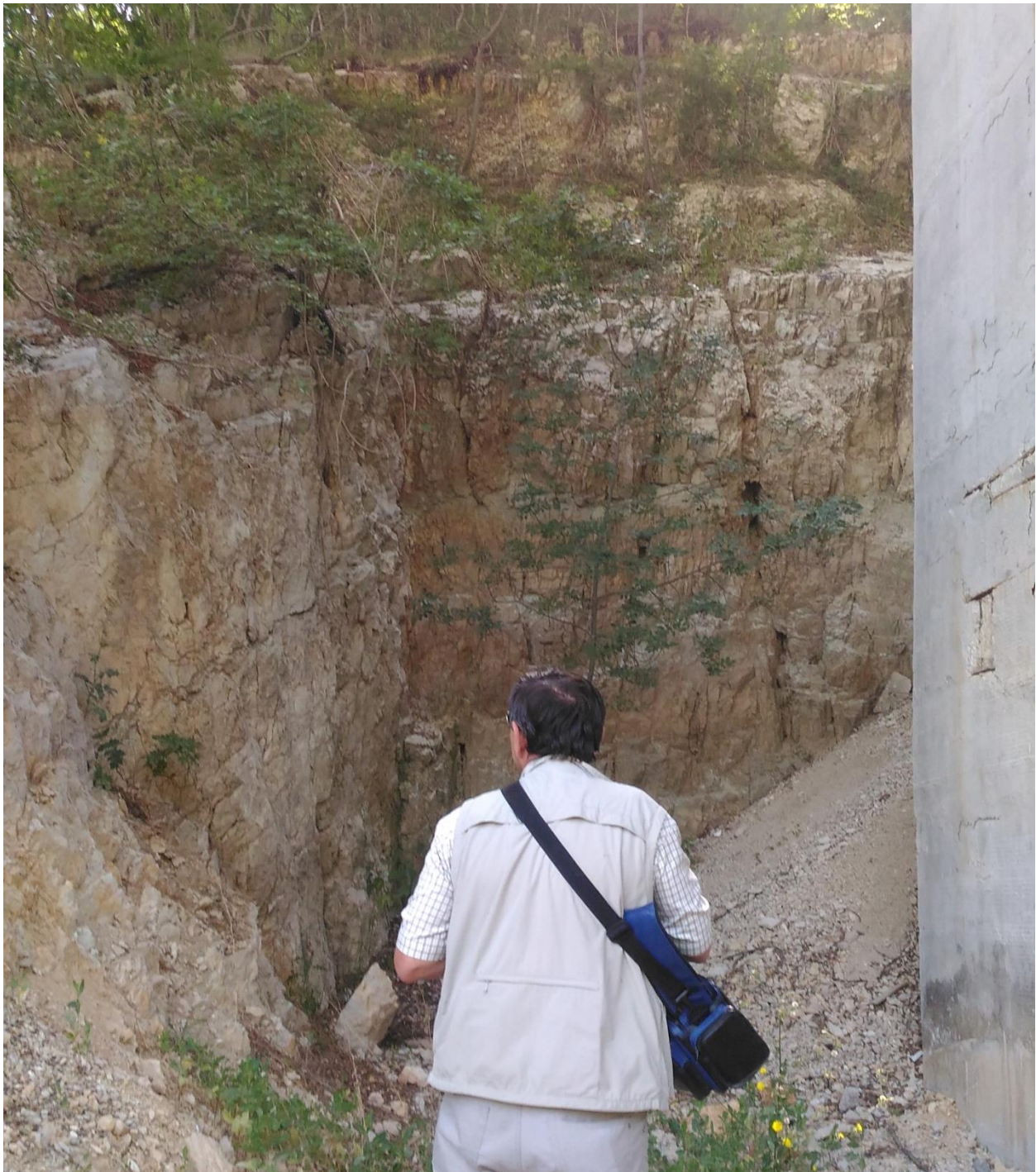
Figura 4 – Ammasso roccioso fratturato affiorante nell'area di sedime del viadotto.
