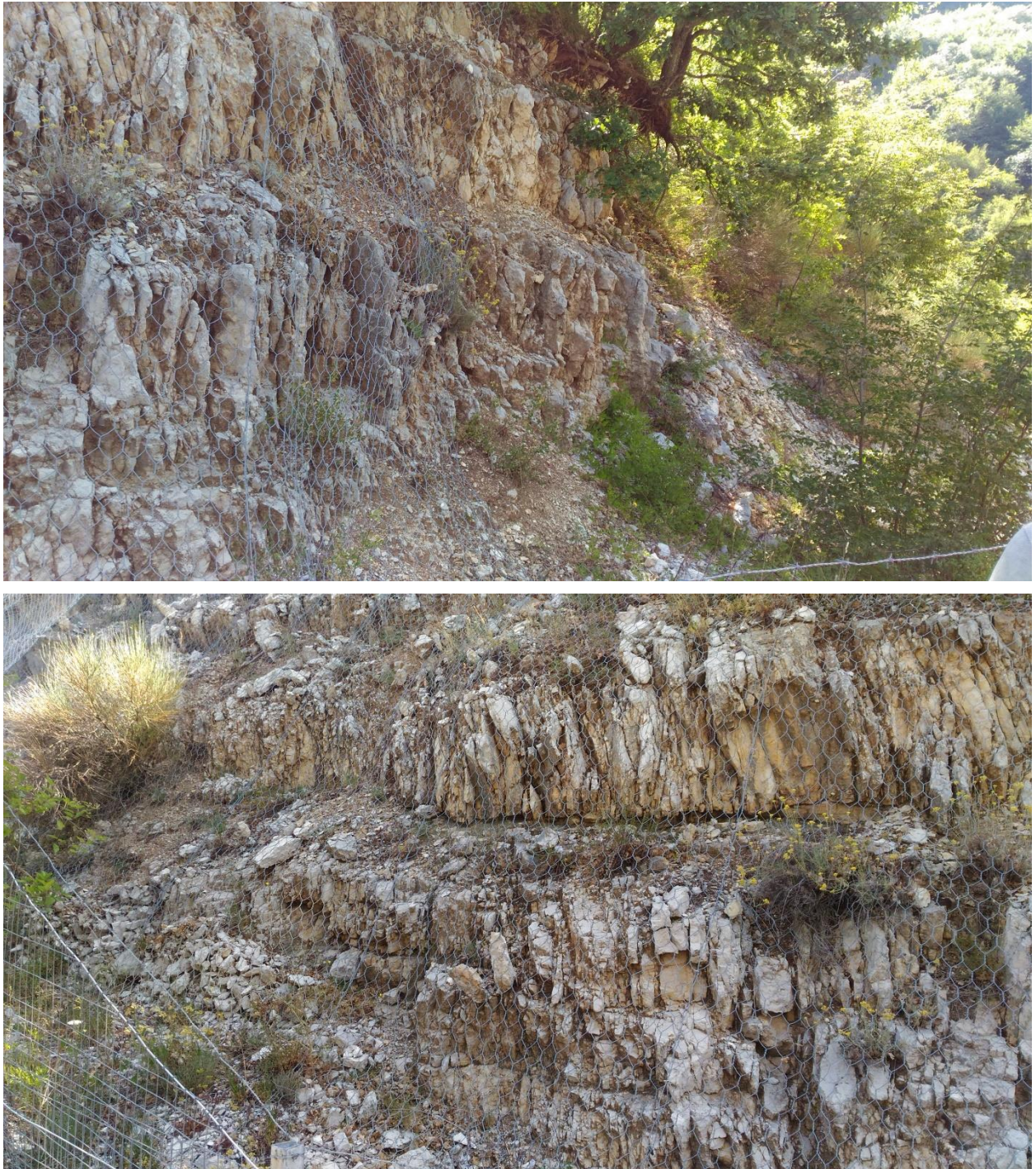
Figura 5 – Ammasso roccioso fratturato affiorante nell'area di sedime del viadotto.
