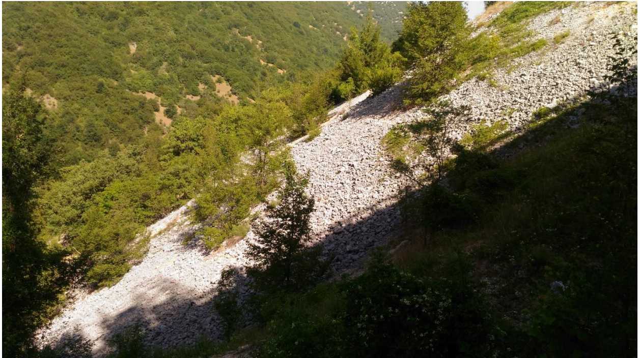
Figura 6 –Coltri detritiche sul versante a valle del viadotto.
