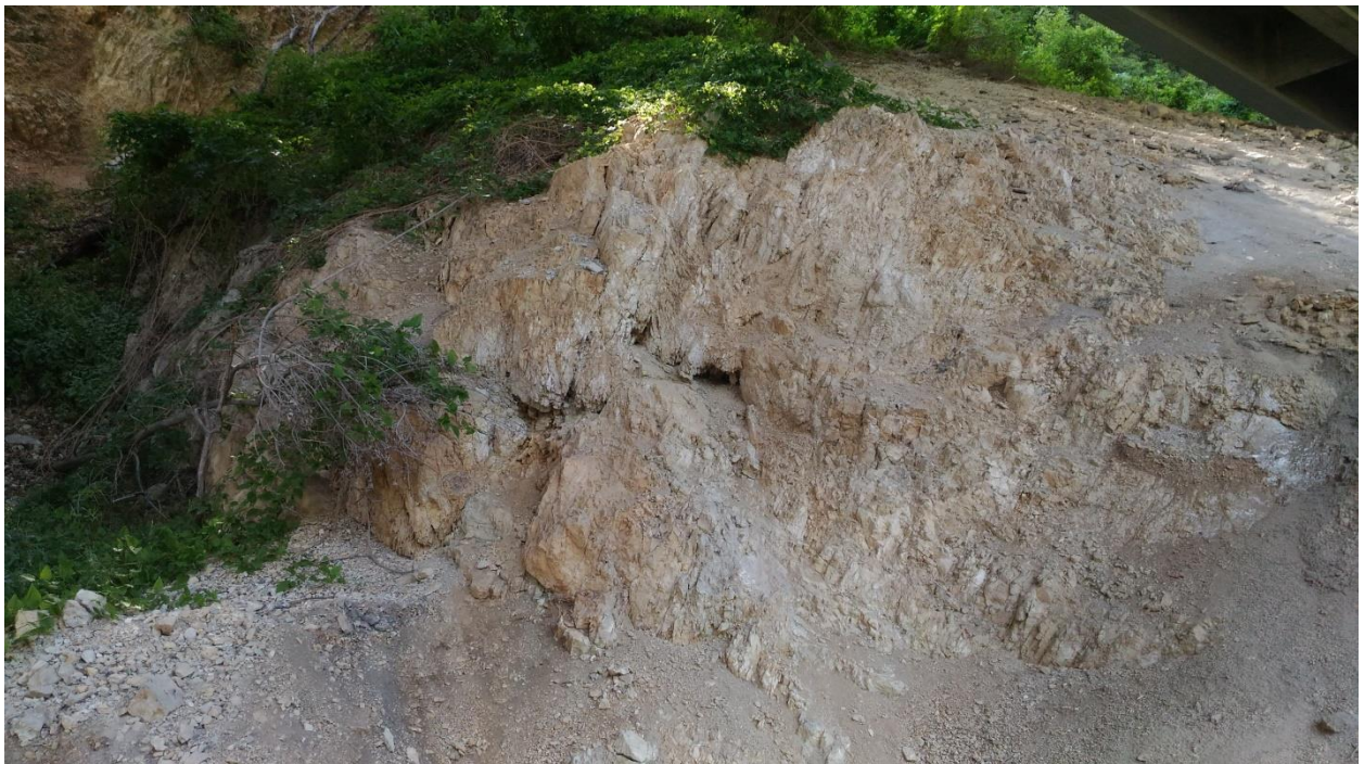
Figura 3 – Ammasso roccioso fratturato affiorante nell'area di sedime del viadotto.
