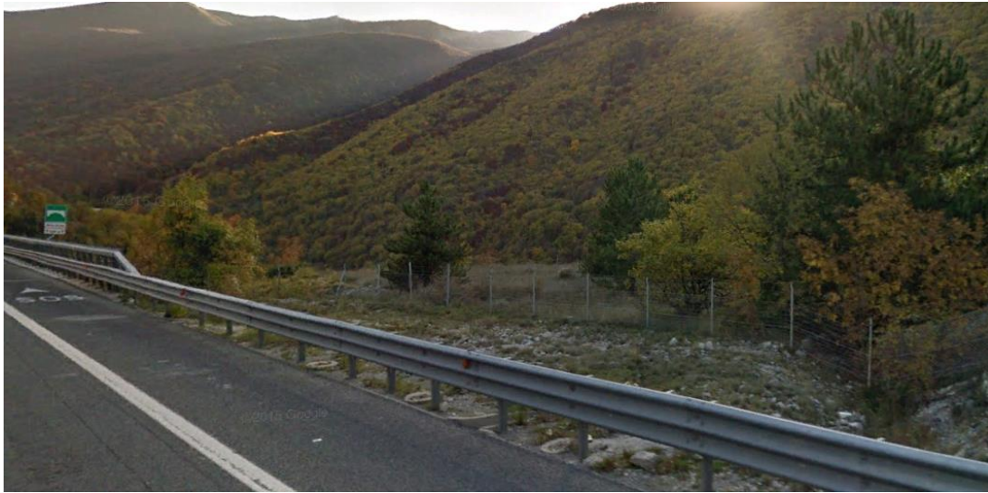
Figura 8: Foto dell' area di posizionamento dell' impianto di trattamento.
