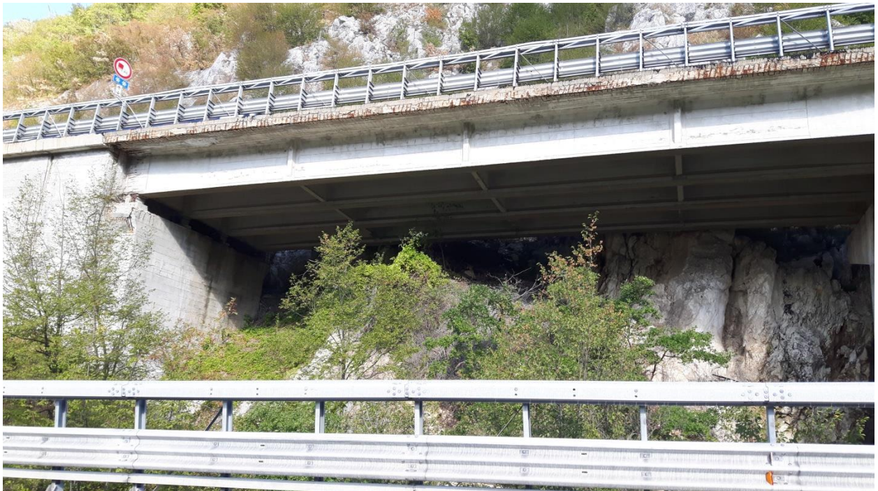
Figura 3 – Affioramento in corrispondenza dell'area del viadotto.
