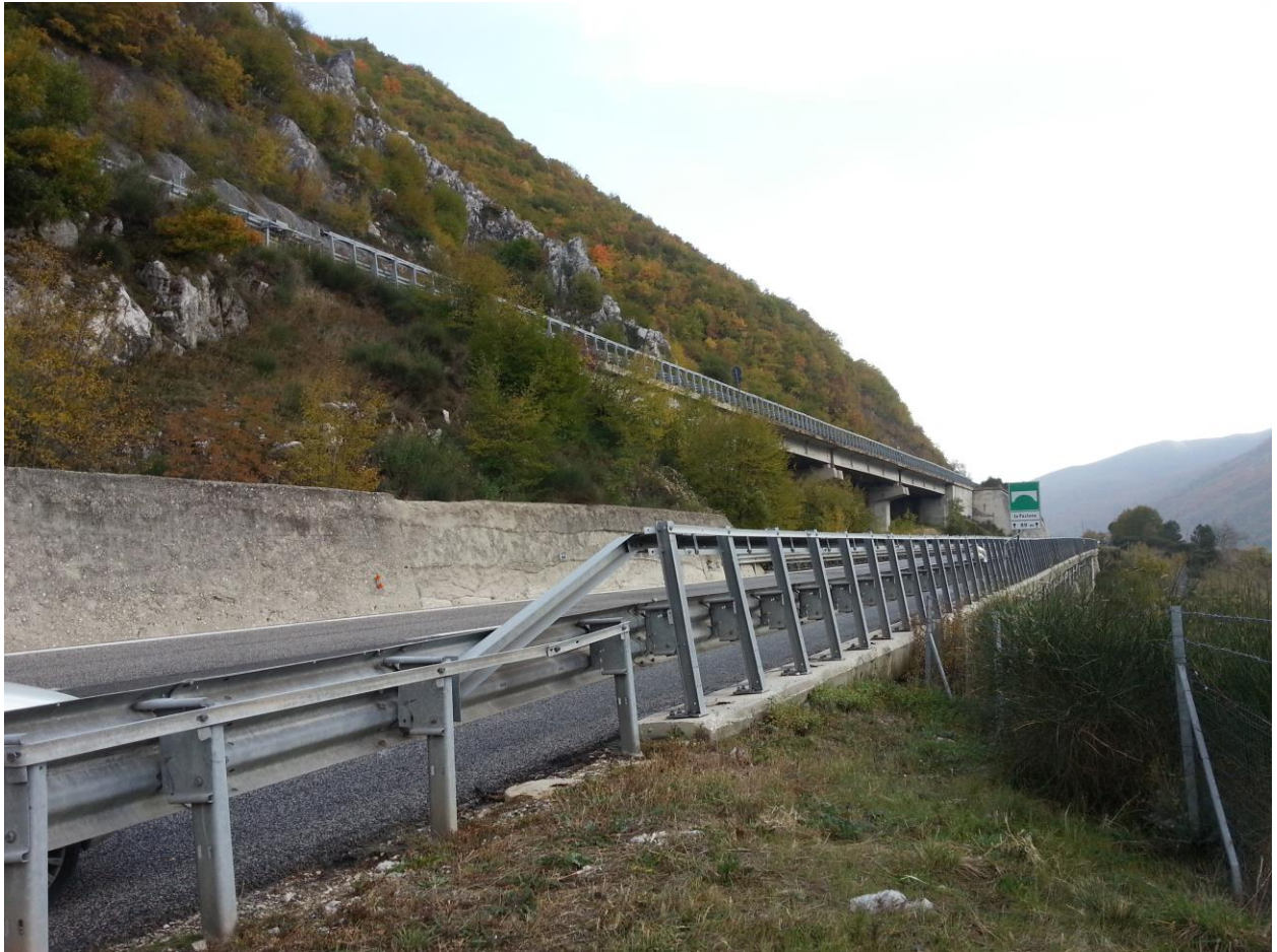
Figura 8 – Vista del Viadotto Le Pastena in corrispondenza della carreggiata autostradale direzione Roma.
