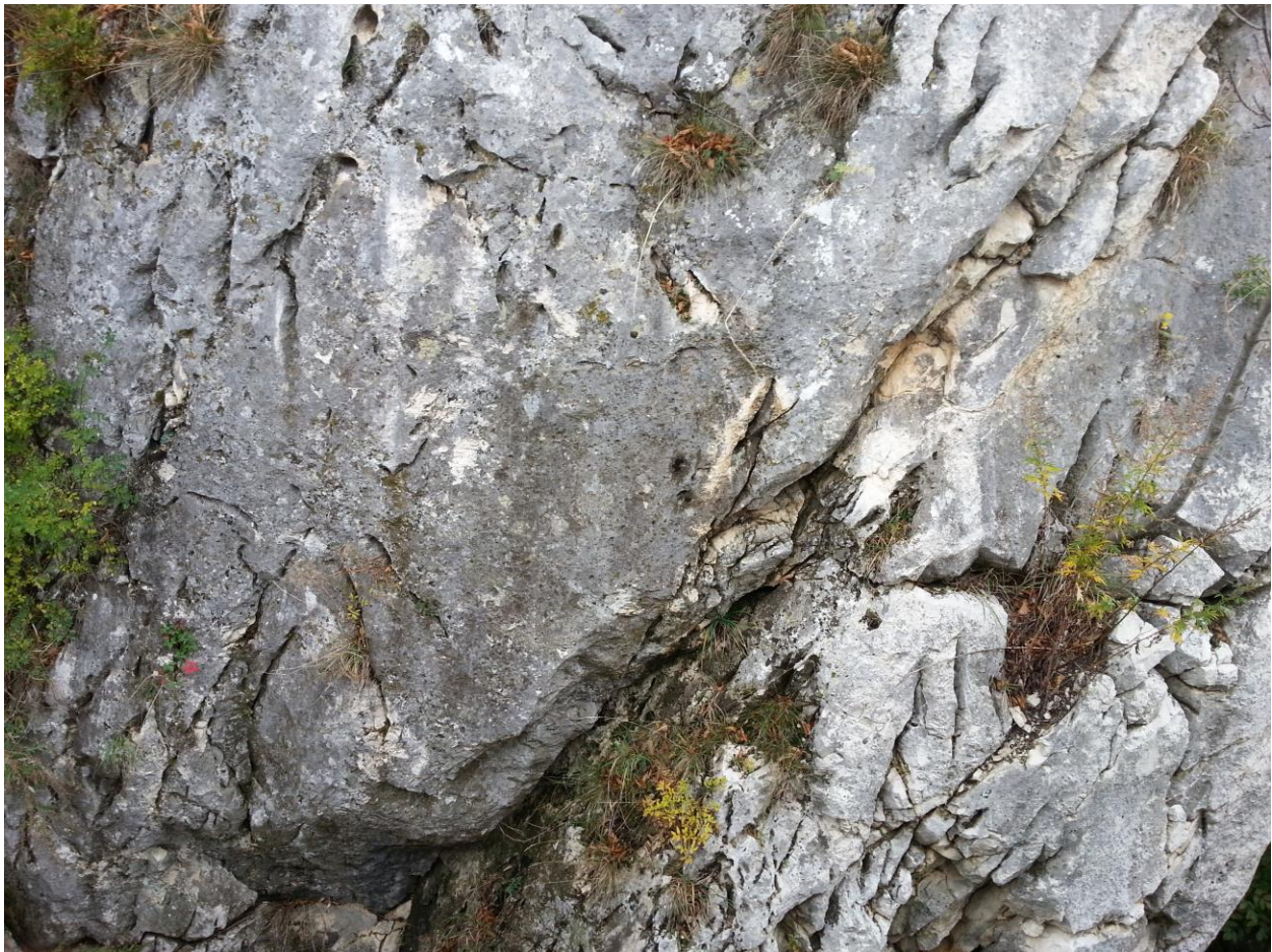
Figura 7 –Particolare dei CCG ed evidenze di carsismo epigeo.
