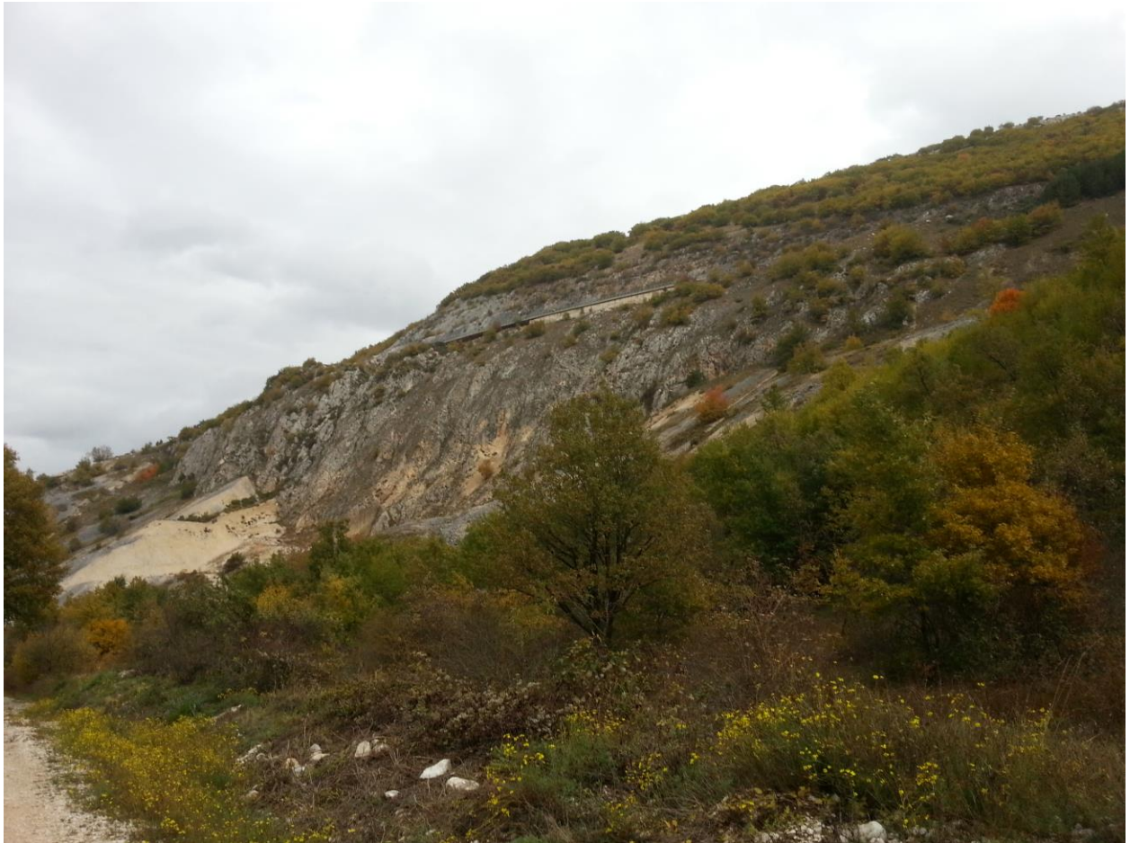
Figura 9 – Vista del Viadotto Le Pastena dalla base del versante.
