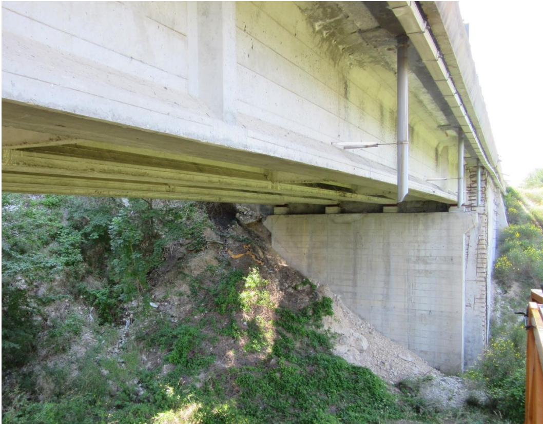
Figura 2: Sistema di drenaggio esistente
