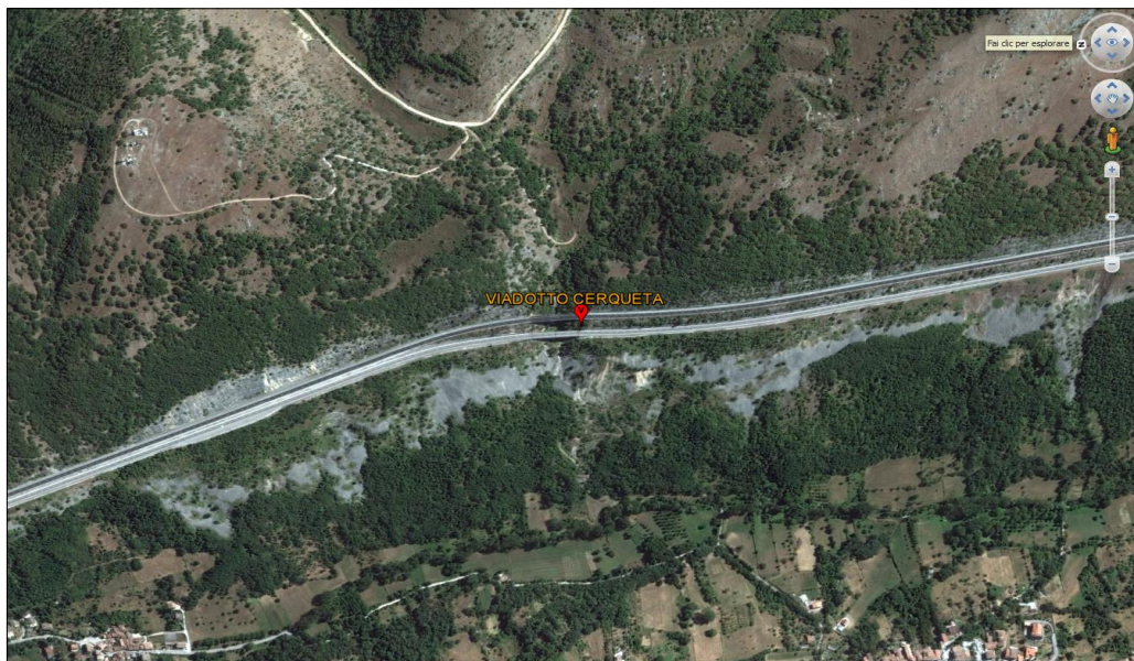
Foto satellitare con ubicazione del Viadotto VI072 Cerqueta
