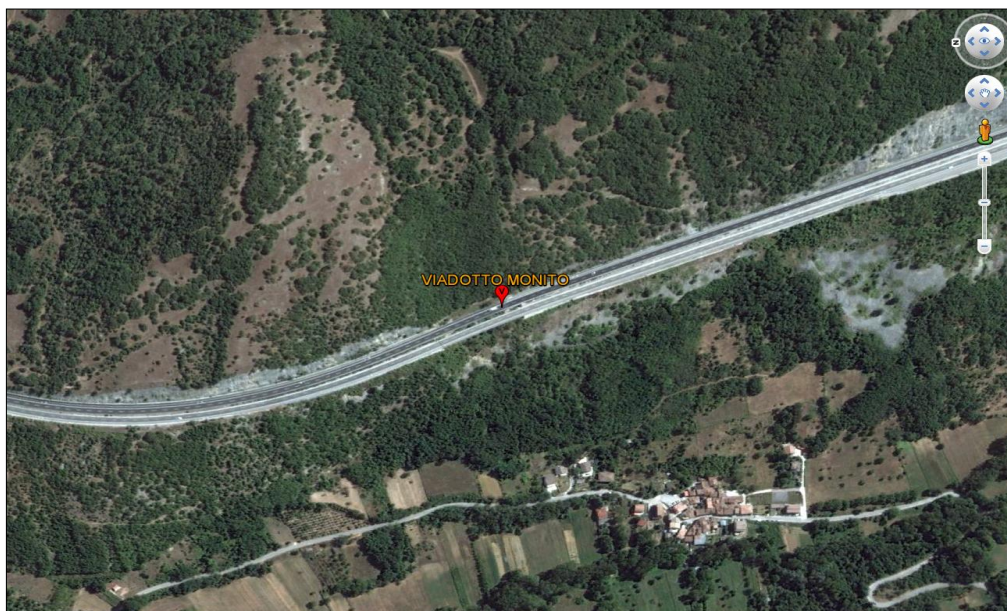
Foto satellitare con ubicazione del Viadotto VI073 Monito
