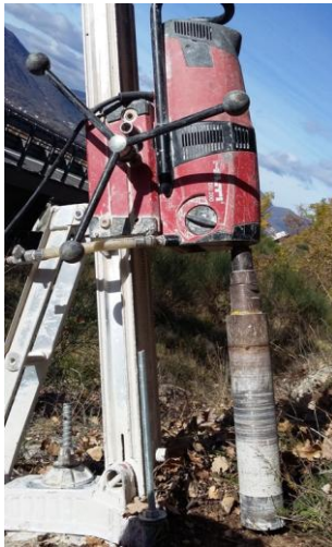
Posizionamento carotatrice
