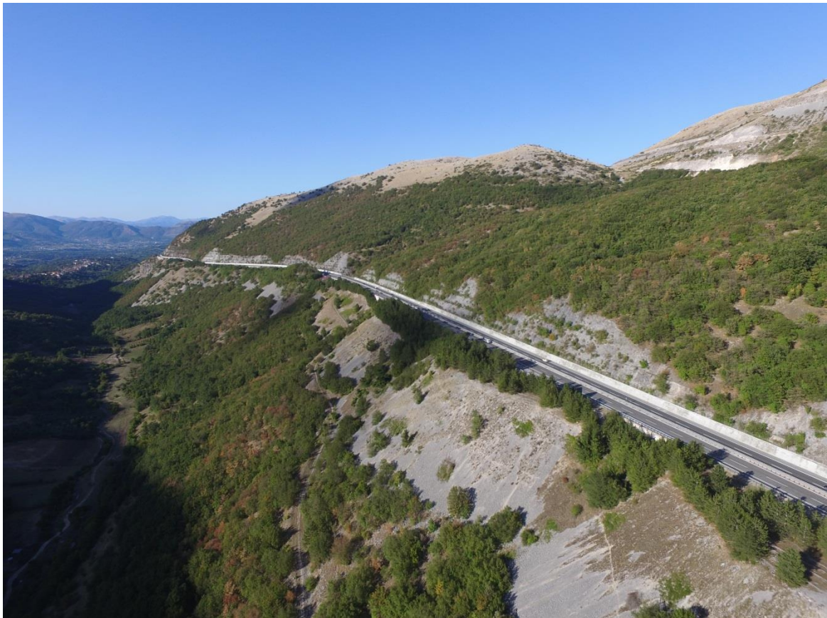
Figura 4. Vista aerea della Valle del T. Raio, in sinistra il versante attraversato dai viadotti autostradali.
