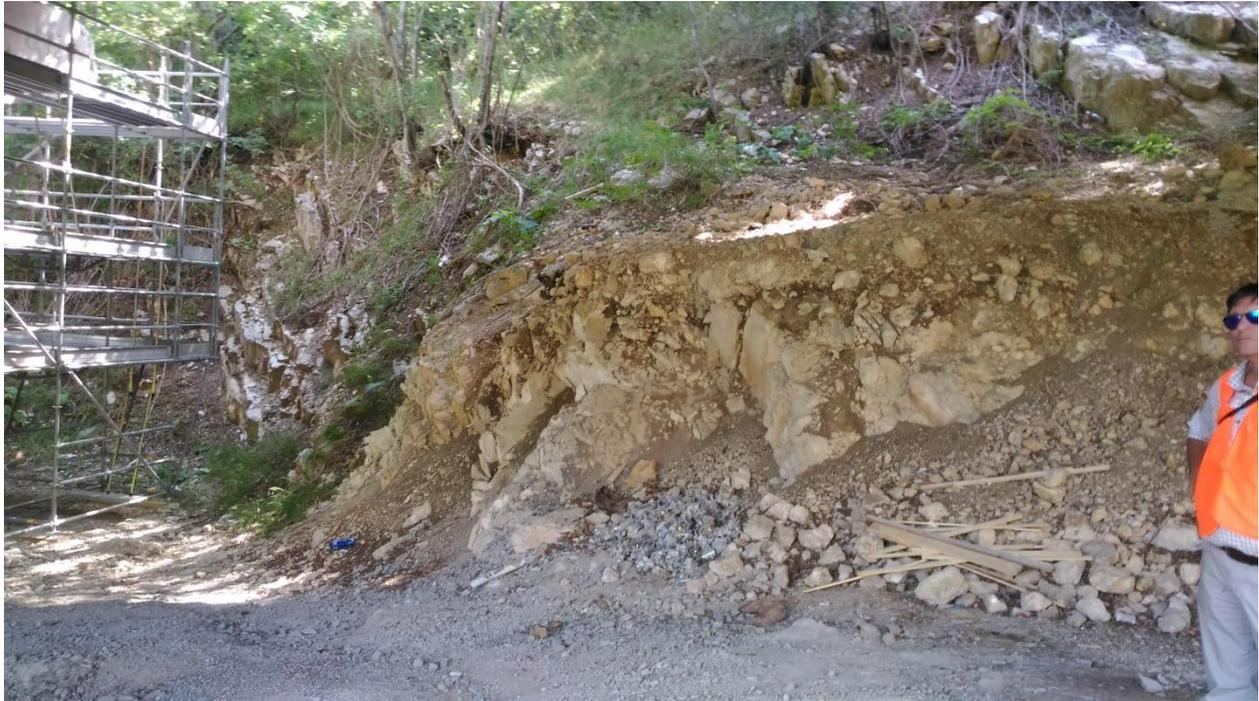
Figura 4 – Affioramento di Calcari a ciclotemi e gasteropodi (CCG) nell'area di sedime del viadotto
