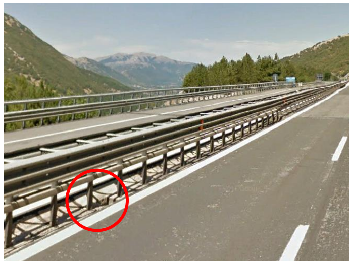
Figura 12: Scarico esistente a monte del viadotto
