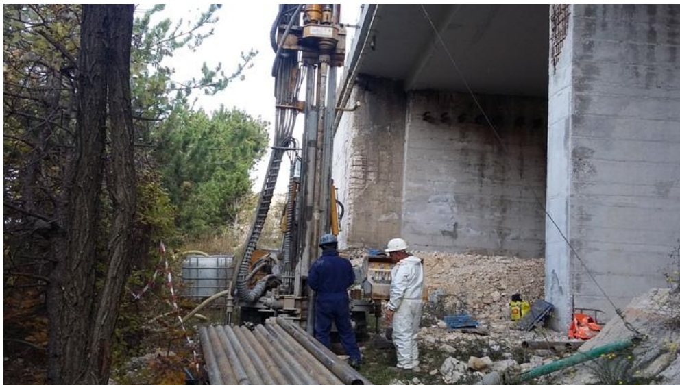
Postazione sulla verticale del sondaggio VI067 S1_DH - Fuggeto
