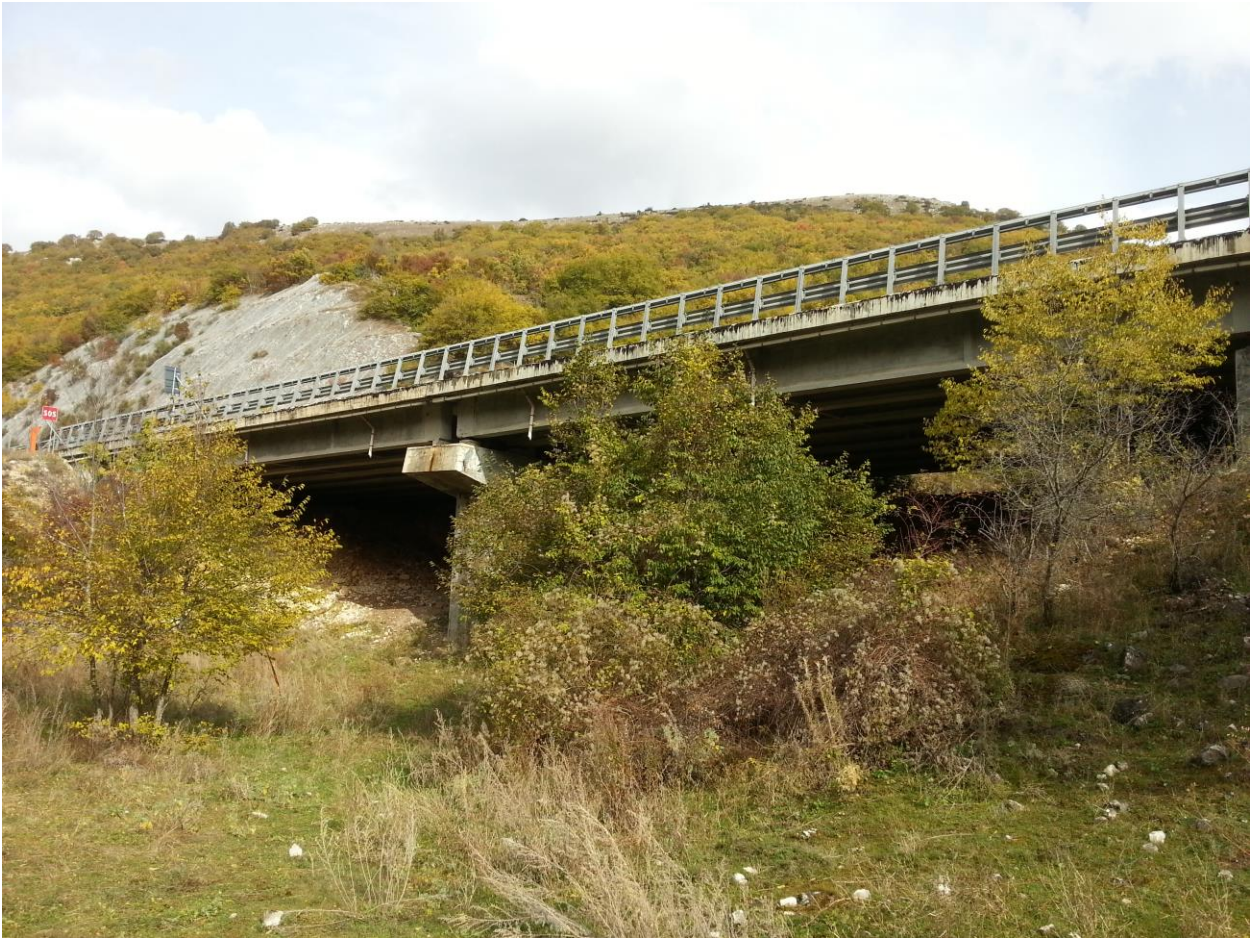
Figura 7 – area di sedime del Viadotto Le Monache.
