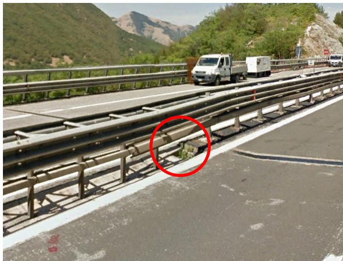
Figura 12: Scarico esistente a monte del viadotto
