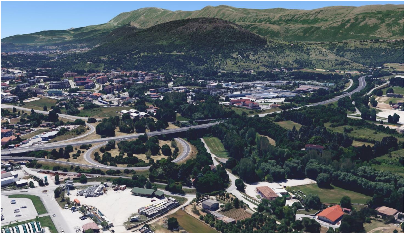
Figura 3: vista d'insieme del tracciato (svincolo dell'Aquila Ovest - il tratto di interesse si sviluppa verso la destra della foto)
