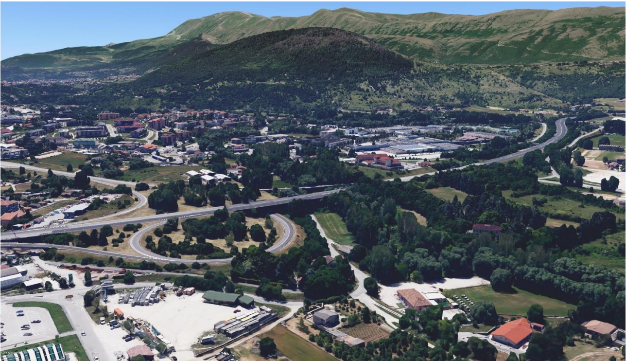
Figura 1 vista d'insieme del tracciato (svincolo dell'Aquila Ovest - il tratto di interesse si sviluppa verso la destra della foto)
