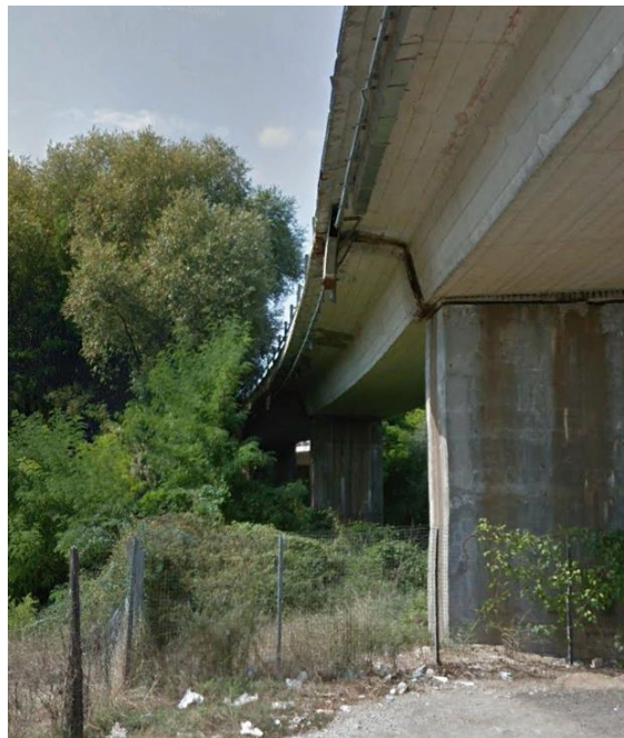
Figura 2: Sistema di drenaggio esistente
