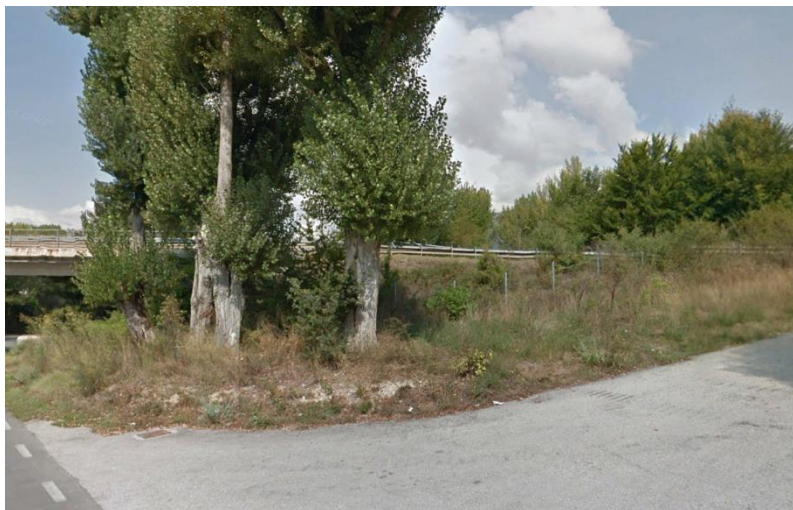
Figura 8: Foto dell' area di posizionamento dell' impianto di trattamento.
