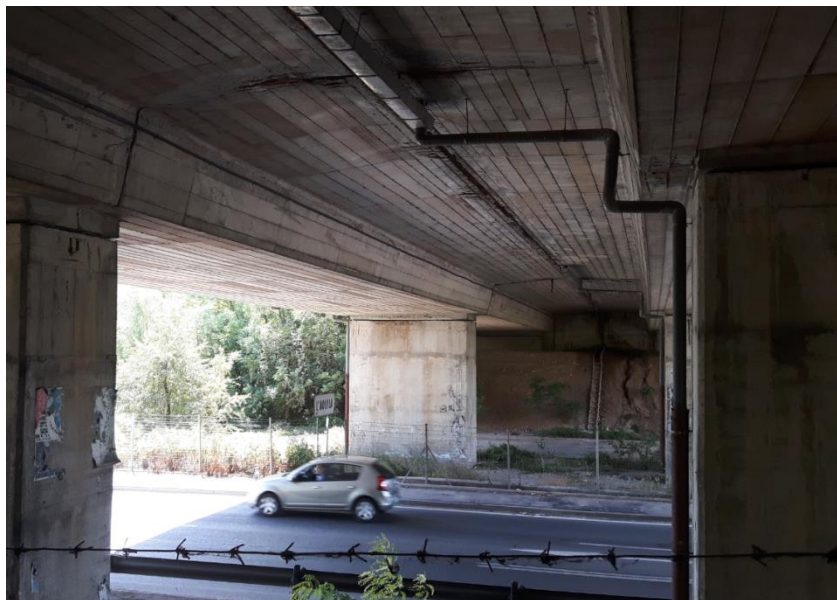
Figura 2: Sistema di drenaggio esistente
