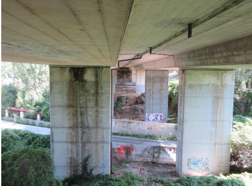
Figura 2: Sistema di drenaggio esistente
