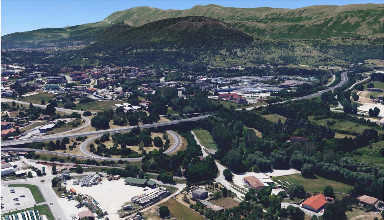
Figura 2: vista d'insieme del tracciato (svincolo dell'Aquila Ovest - il tratto di interesse si sviluppa verso la destra della foto)
