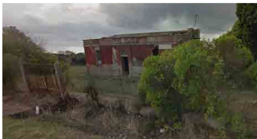
Casa cantoniera, identificata dal PPR quale bene identitario, posta al km 1+000 lungo la SS 195
