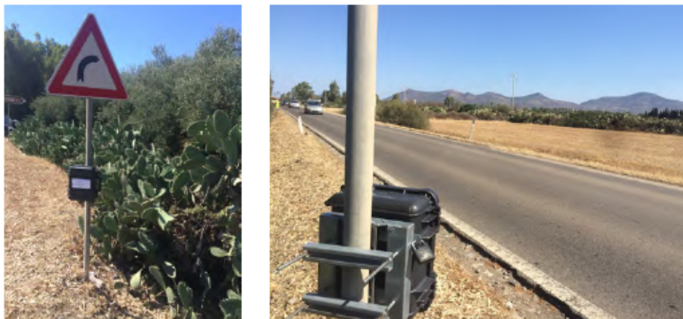
Figura 9 Installazione del contatraffico sulla SS 195
