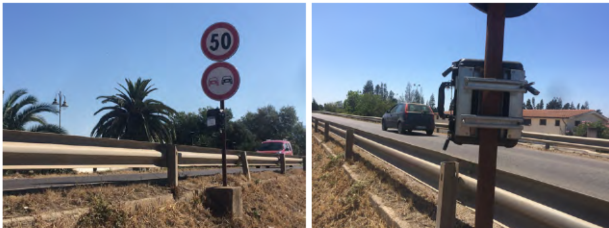
Figura 12 Installazione del contatraffico sulla SS 293 tratto Giba-Piscinas
