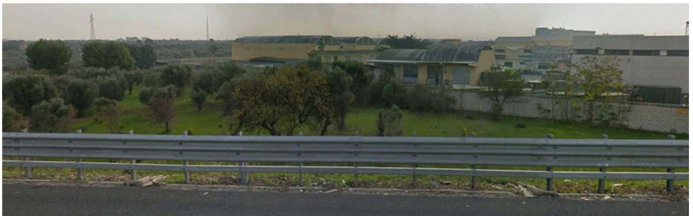
Vista dell'area in cui si inserisce il cantiere dalla tangenziale di Bari
