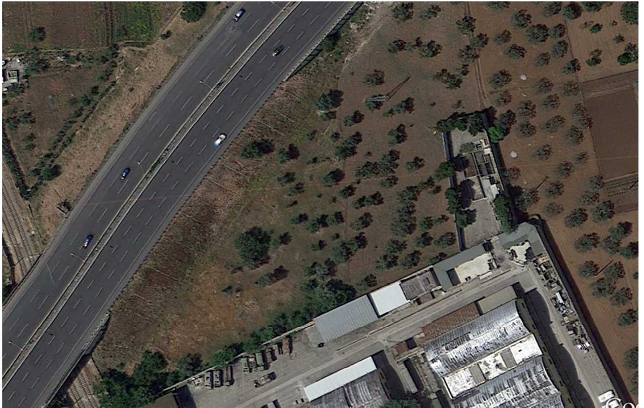
Vista aerea dell'area destinata al cantiere
