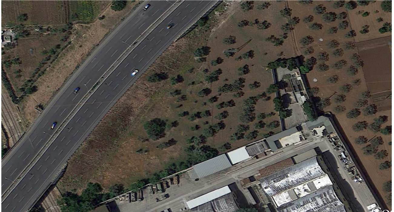
Vista aerea dell'area in cui si inserisce il cantiere
