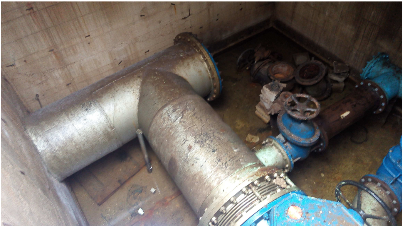
Figura 7-1 Camera di manovra lato monte, stato di fatto
