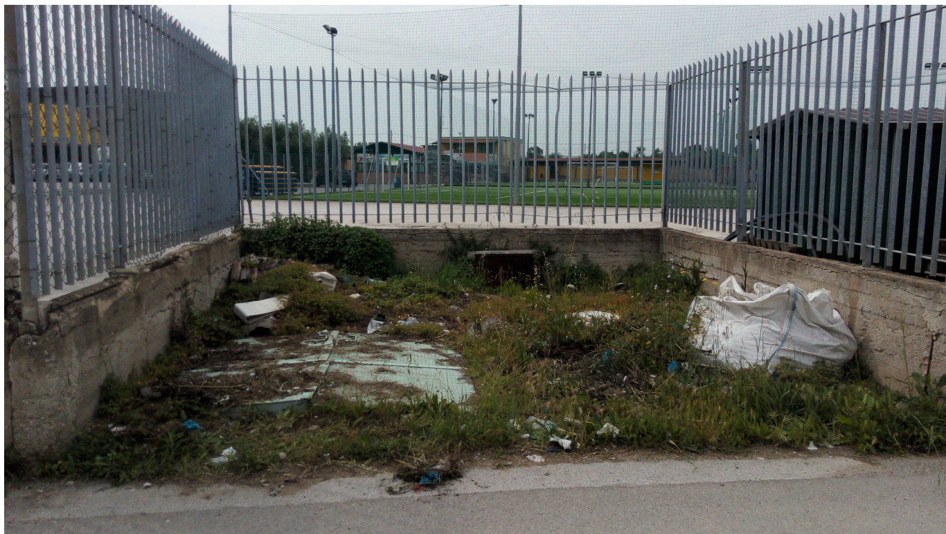
Figura 7-2 Botola pozzetto lato monte, stato di fatto
