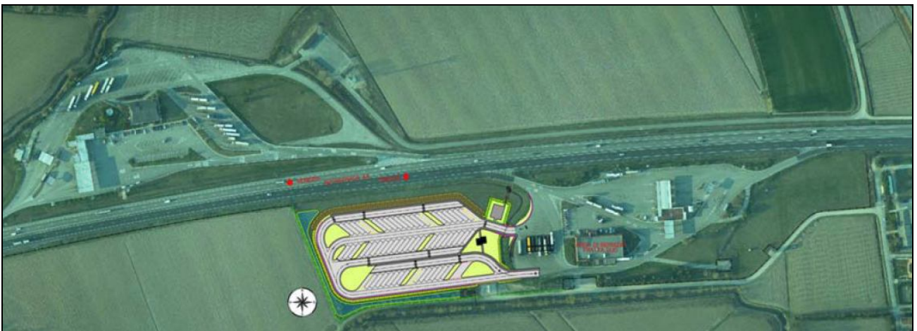
Fig. 3.8 – Area di sosta Fratta Sud
