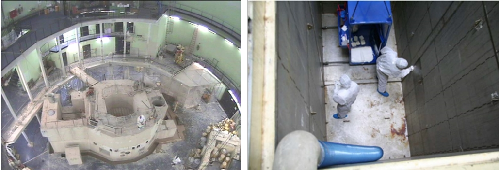
Abbildung 2: Rückbau des Forschungsreaktors ASTRA und des Brennelementlagerbeckens
