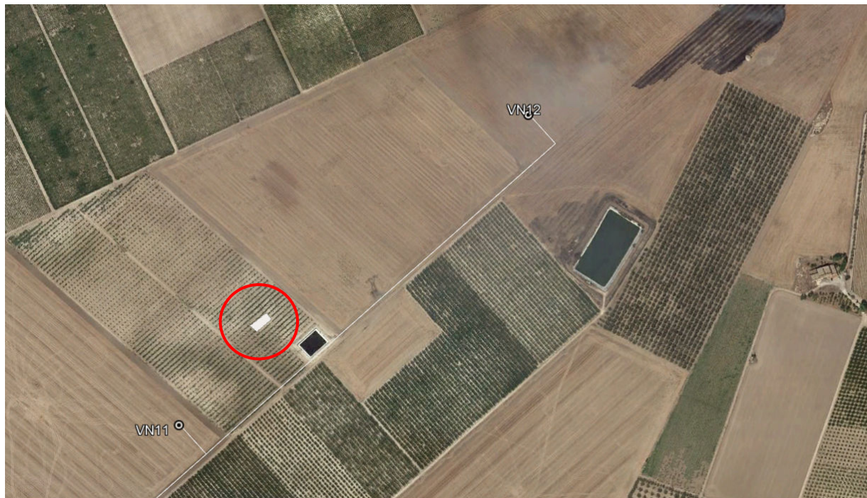
Fig. 2.6B - Vista dall'alto con sovrapposizione degli aerogeneratori VN11 e VN12 e del sito storico culturale (area cerchiata in rosso) come individuato nel PPTR (Fonte Google)
