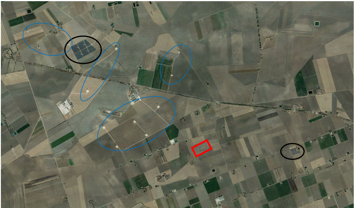
Fig. 6.3 - Vista dall'alto con individuazione dell'area del bene (in rosso) e degli impianti eolico (in blu) e fotovoltaici (in nero) esistenti. Non risulta presente alcun fabbricato. (fonte Google)
