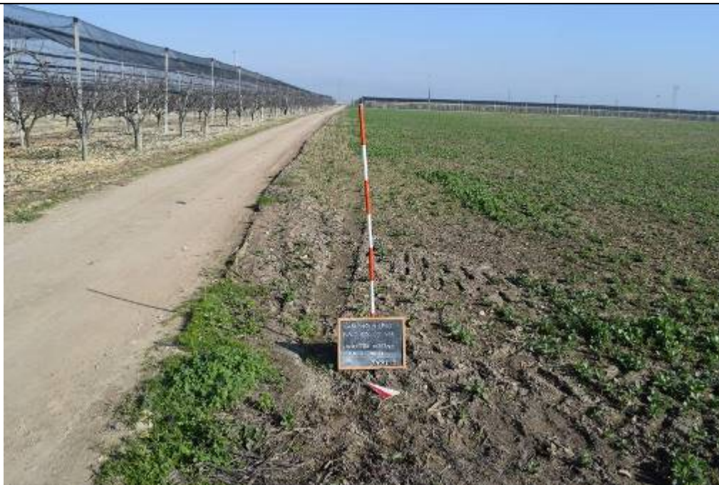
Foto 64 : cavidotto di collegamento VN 10 - VN 11, vista da SO
