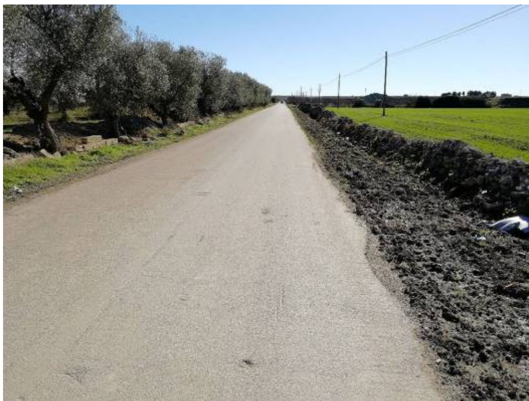
Foto 74 La parte meridionale del tratto di cavidotto vista da N
