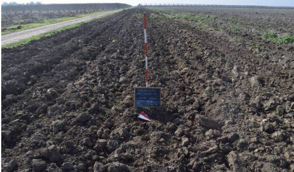
Foto 66 cavidotto di collegamento VN 10 - VN 11, vista da NE
