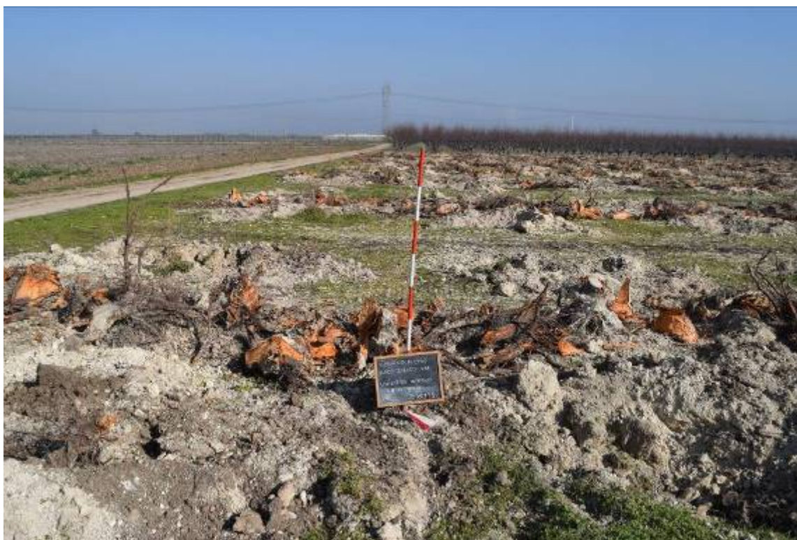
Foto 65. cavidotto di collegamento VN 10 - VN 11, vista da SO.
