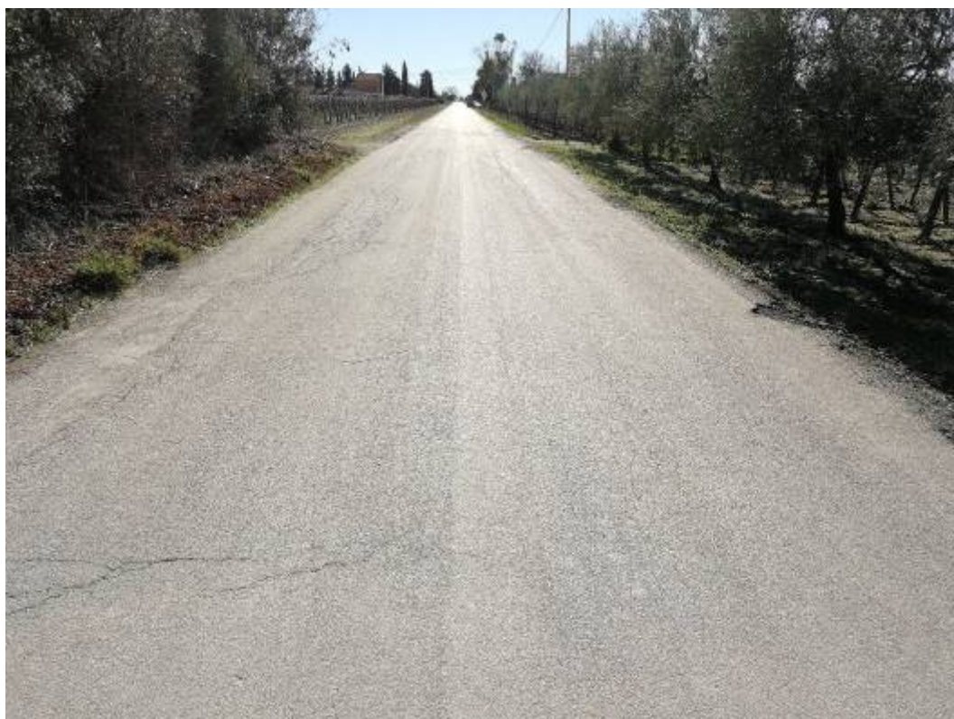
Foto 76 La parte centro-settentrionale del tratto di cavidotto vista da N
