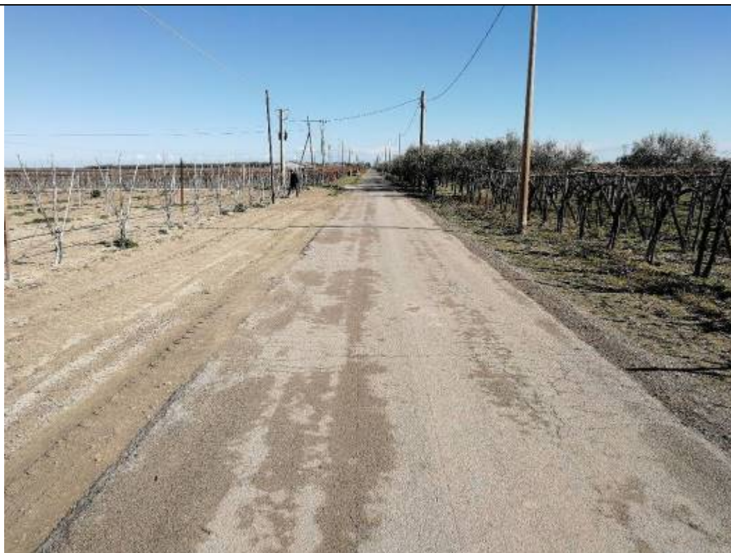
Foto 81 La parte sud-occidentale del tratto di cavidotto considerato vista da NE
