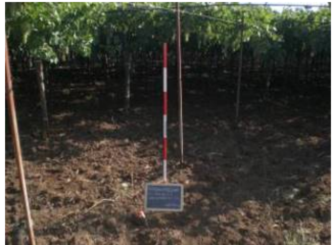
Foto 5-6 Cavidotto di accesso a VN01 visto da N e da S
