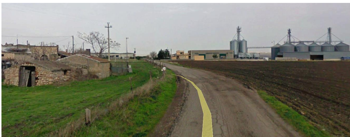
Figura 4 – Attraversamento cavidotto interno in area di rispetto "Masseria Catenaccio" – SP104
