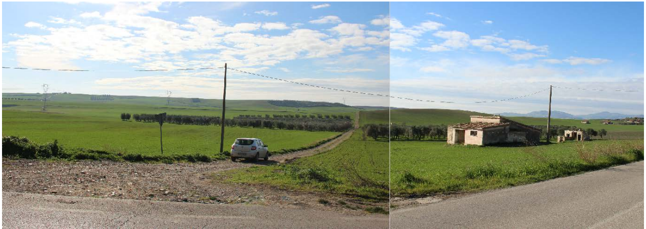
Figura 4 – vista dell'area di impianto dalla SP110 in corrispondenza della strada di accesso al gruppo delle torri C1- C2- C10
