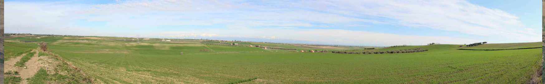
PAN 4 - Aerogeneratore C5
