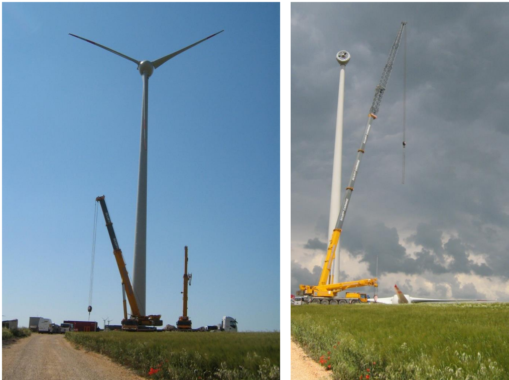
Figura 2: rimozione eliche e mozzo
