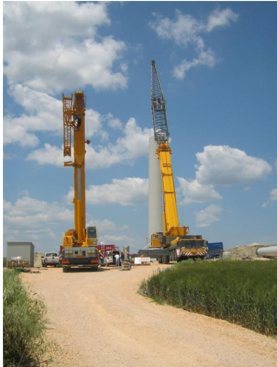
Figura 4: particolare smontaggio torre
