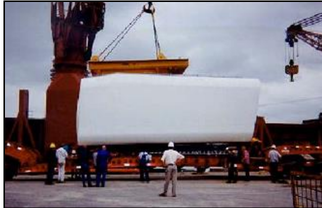
Figura 10: trasporto della navicella
