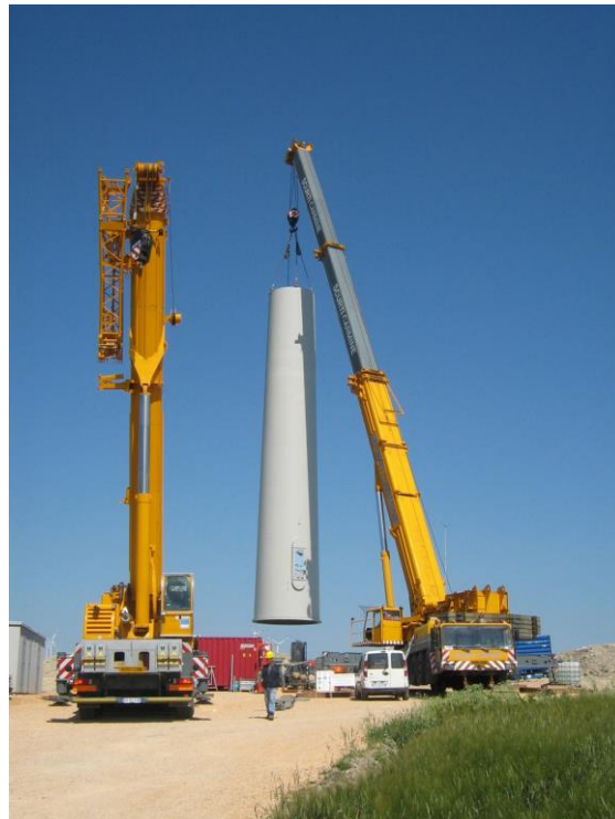
Figura 5: elemento torre smontata da trasportare
