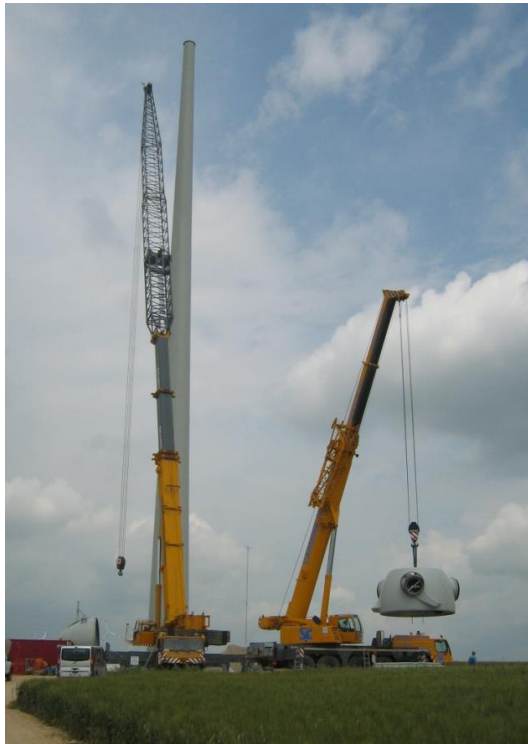
Figura 3: smontaggio navicella
