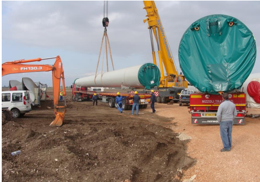
Figura 6: elementi torre smontata da trasportare
