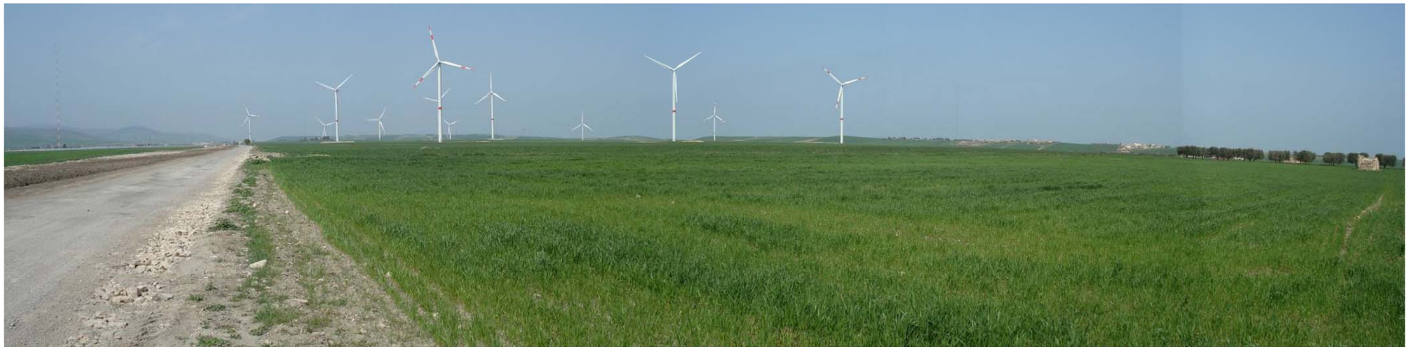
In alto, la Stazione Elettrica 380/150 kV di Deliceto; in basso, impianto eolico in agro di Deliceto lungo la SP 103 verso Castelluccio dei Sauri.
