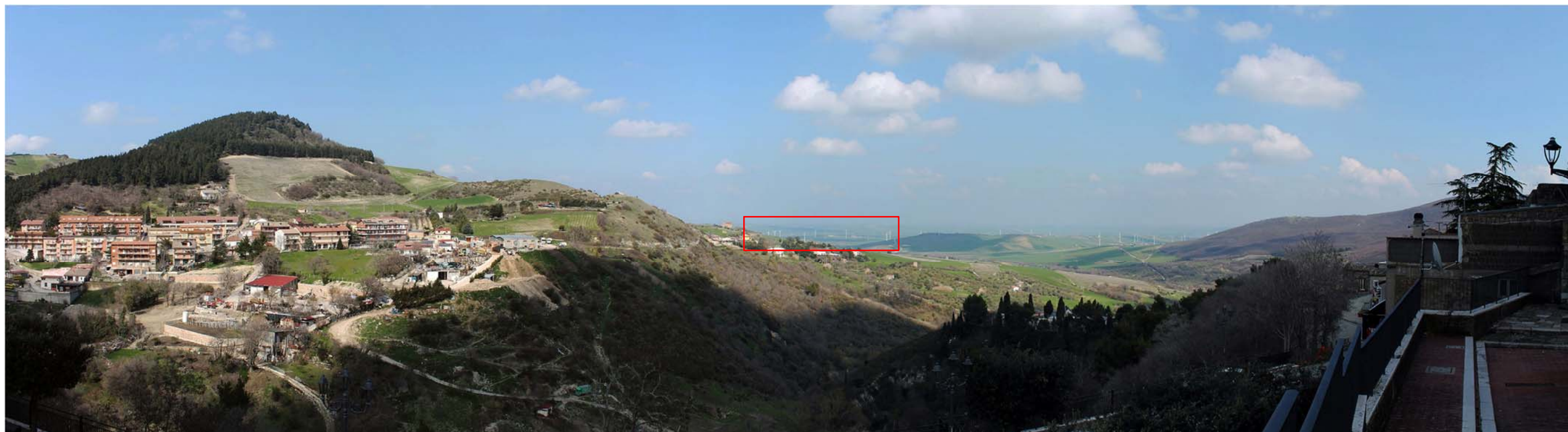
Panoramica 02a _ Vista dal centro abitato di Deliceto, a circa 9 km dall'impianto (che occupa la porzione di territorio compresa nel riquadro rosso; data la distanza le torri non sono inserite in quanto indistinguibili). Dal belvedere posto immediatamente sotto il Castello, si aprono visuali obbligate verso valle. Si evidenzia che data la prospettiva della vista, dall'alto verso il basso, anche i tanti aerogeneratori già realizzati e molto più vicini al centro abitato rispetto all'impianto in progetto, vengano riassorbiti percettivamente dallo sfondo. L'impianto dista circa 9 km, e la distanza è tale da non determinare alterazioni significative delle viste panoramiche verso il Tavoliere.
