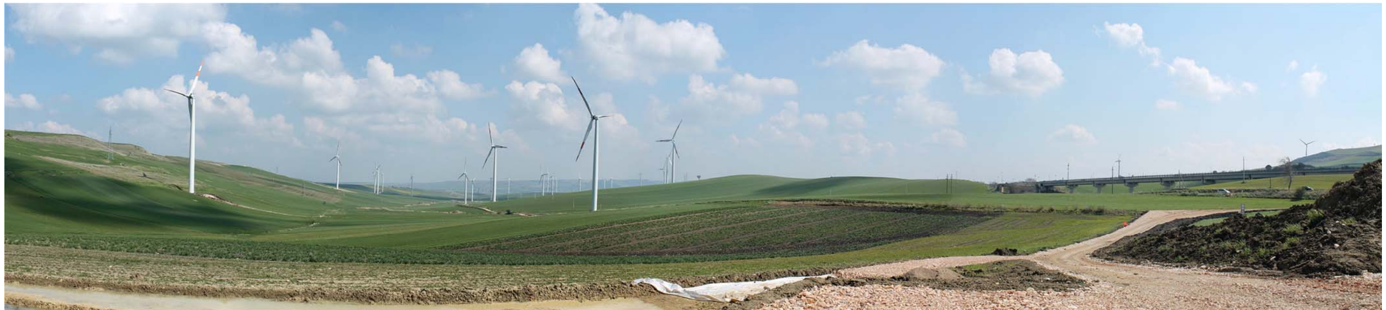
Viste degli impianti eolici realizzati in aree prossime alla Stazione Elettrica RTN 380/150 kV di Deliceto. Aerogeneratori e infrastrutture elettriche connotano ormai da oltre 15 anni i luoghi e sono parte integrante del paesaggio.
