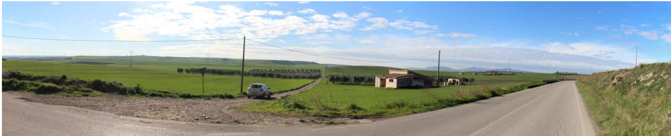
Figura 2: Panoramica dell'area d'impianto dalla SP 110 in corrispondenza della strada di accesso alle torri C1 C2 C10
