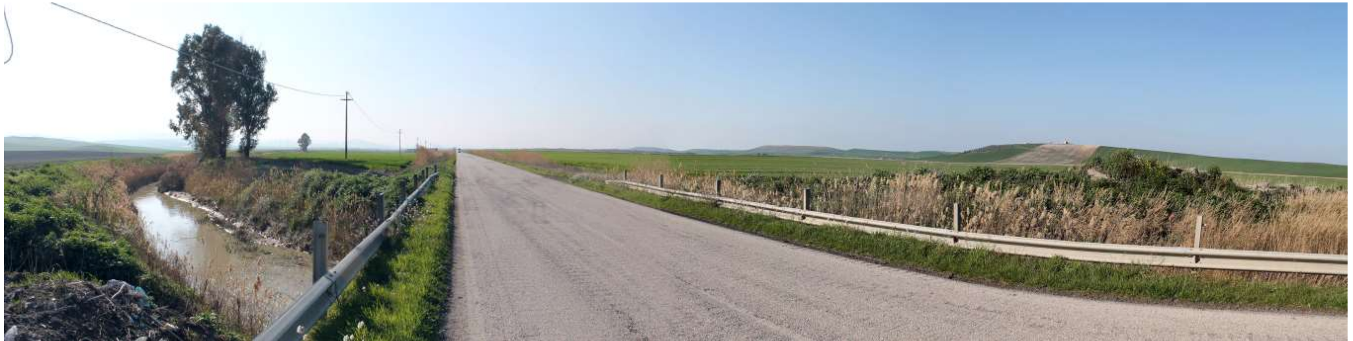
Panoramica da SP 106 in corrispondenza dell'attraversamento del Torrente Carapellotto – STATO DEI LUOGHI
