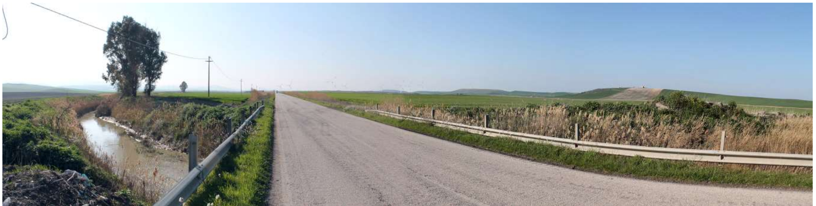
Panoramica da SP 106 in corrispondenza dell'attraversamento del Torrente Carapellotto – FOTOMONTAGGIO
