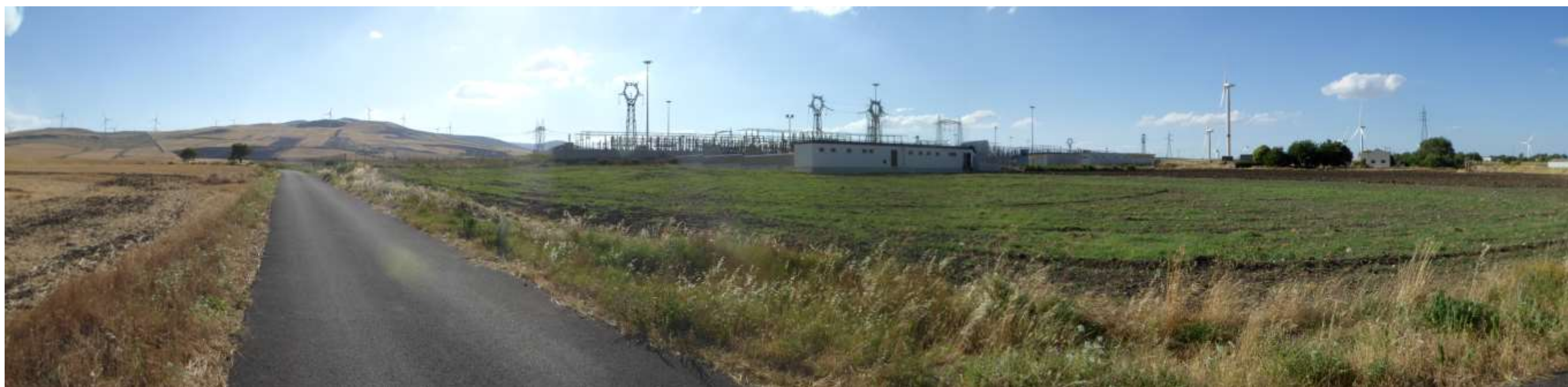
Figura 7: Panoramica dell'area della stazione RTN Deliceto
