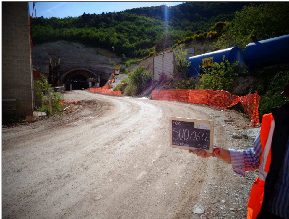
Imbocco est galleria "Valico di Fossato" ex cantiere "La Serra"
