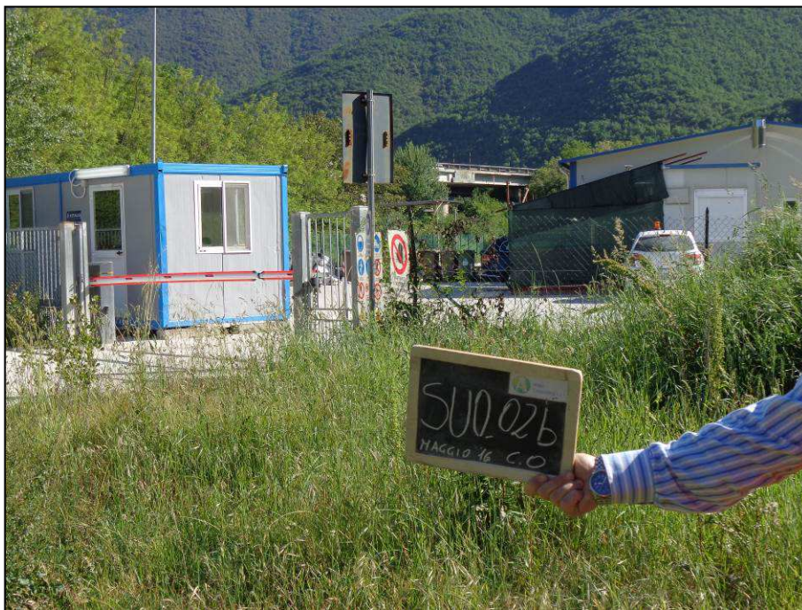
Area di cantiere campo base "Borgo Tufico"
