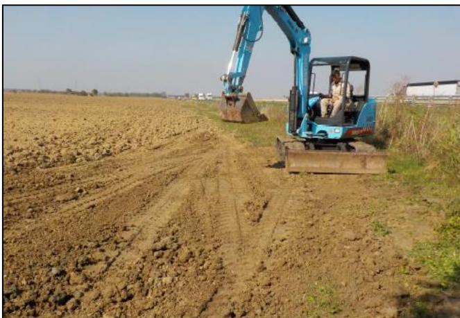
Area di localizzazione del pozzetto.
