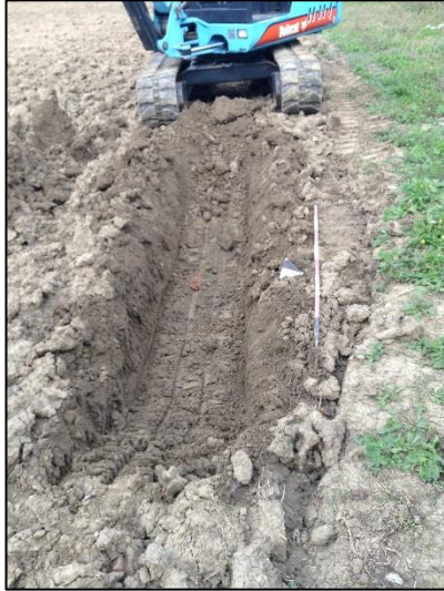
Pozzetto visto da est, profondità m 0,50
