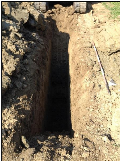
Pozzetto visto da est, profondità m 3,80
