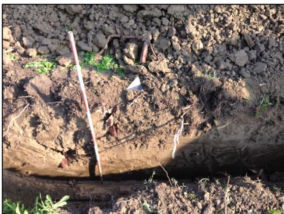
Parete est vista da ovest, profondità m 1,00
