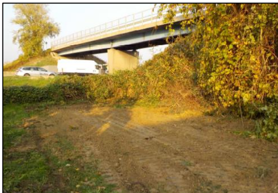
Area di localizzazione del pozzetto.
