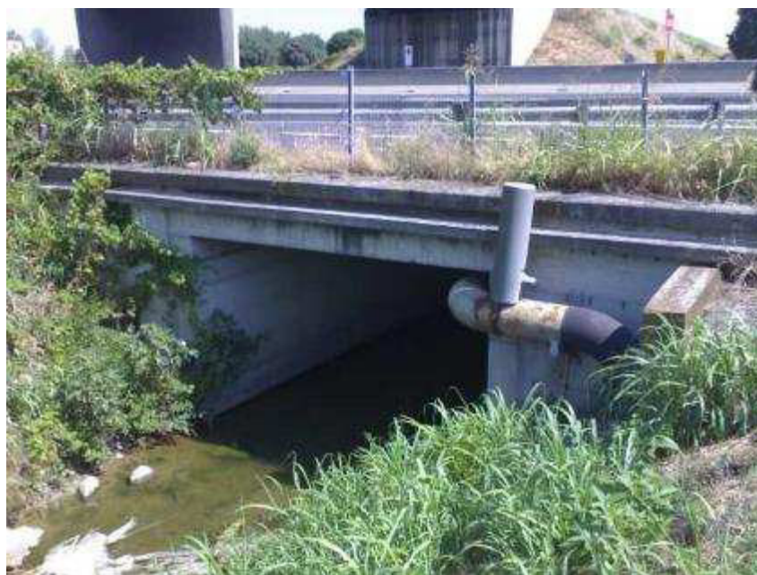
Figura 7-4. Scolo Consorziale Gambellara in corrispondenza dello scatolare autostradale
