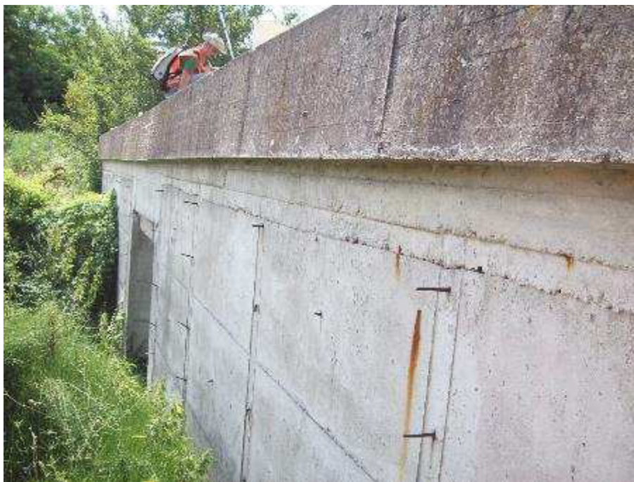
Figura 6-4. Fossa di Mezzo in corrispondenza dello scatolare autostradale
