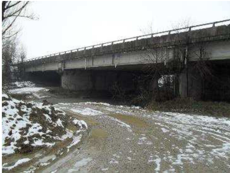
Figura 5-20. Viadotto autostradale del Torrente Sillaro nello stato di fatto
