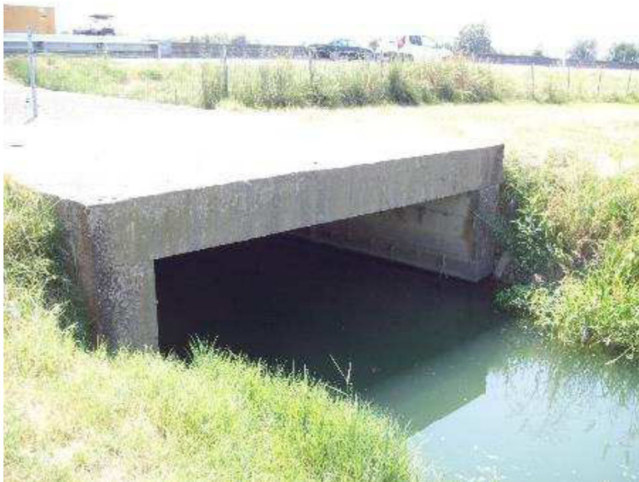
Figura 6-22. Scolo Laghetto in corrispondenza dello scatolare autostradale
