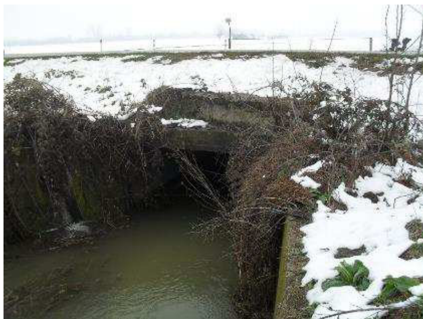
Figura 5-9. Scolo Fossazza in corrispondenza dello scatolare sulla strada provinciale Colunga a valle dell'A14
