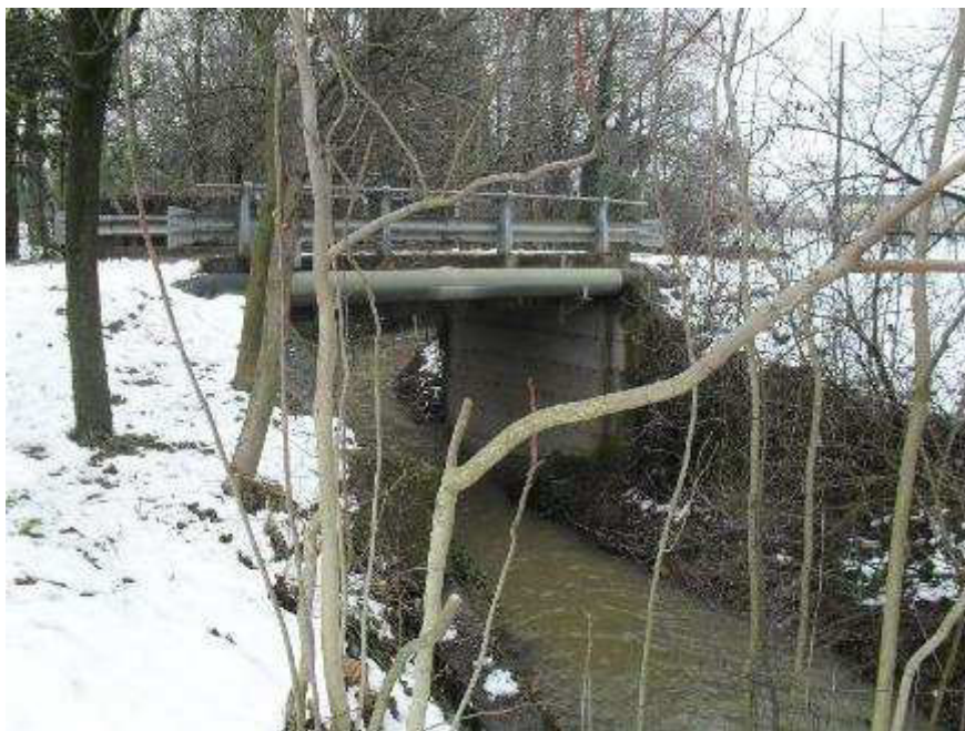
Figura 5-27. Rio Sabbioso a valle dell'autostrada A14
