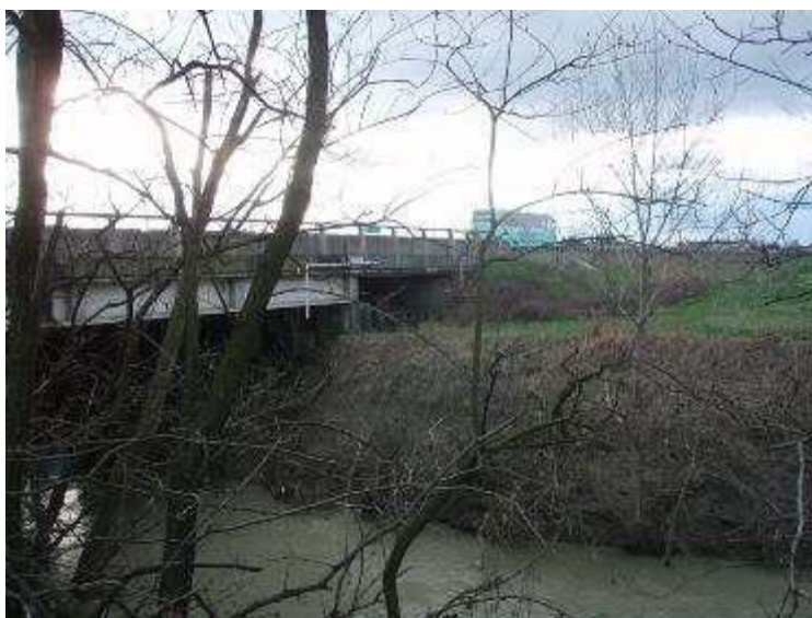
Figura 5-39. Torrente Santerno in corrispondenza del Ponte autostradale
