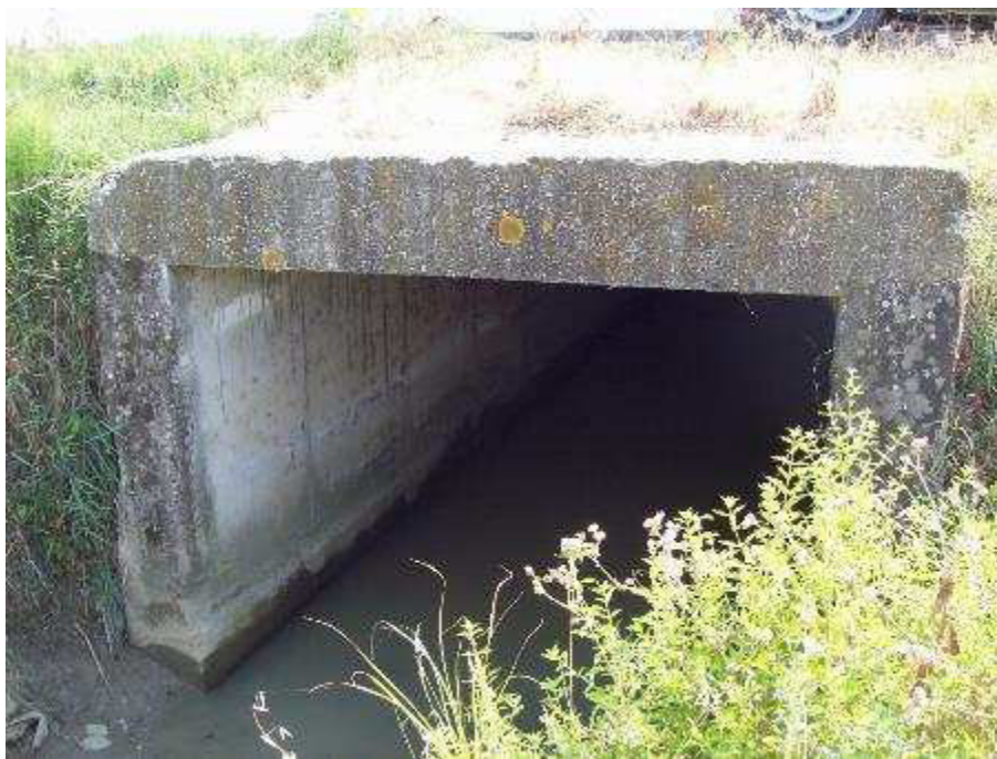
Figura 6-16. Fossa Galisano in corrispondenza dello scatolare autostradale
