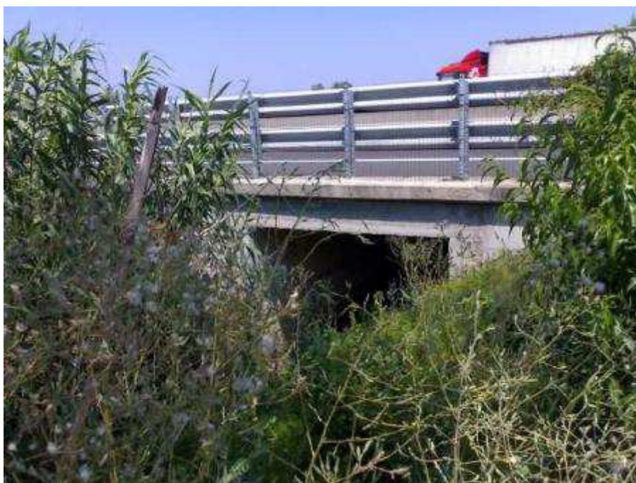
Figura 6-43. Fossa delle Brunelle in corrispondenza dello scatolare autostradale
