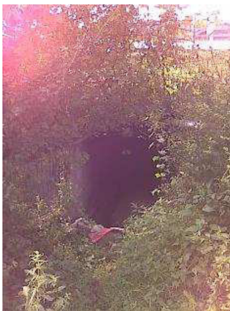
Figura 7-18. Condottello di Bagnara in corrispondenza dello scatolare autostradale
