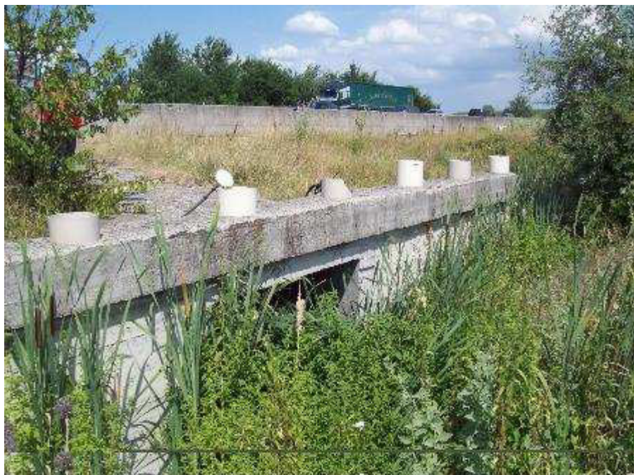
Figura 6-1. Scolo Fossadone in corrispondenza dello scatolare autostradale
