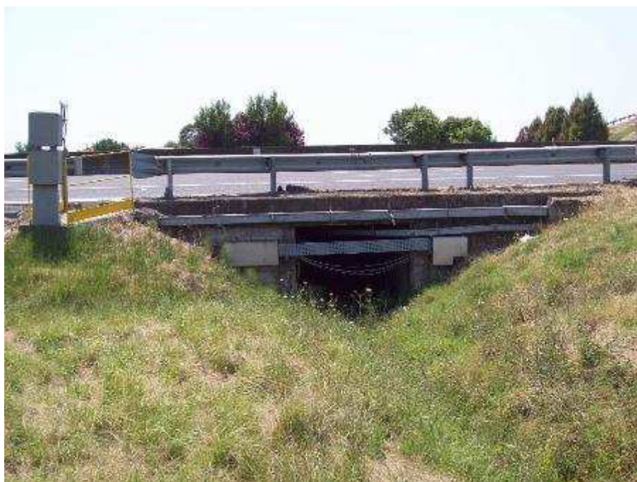
Figura 6-28. Fosso 23 in corrispondenza dello scatolare autostradale
