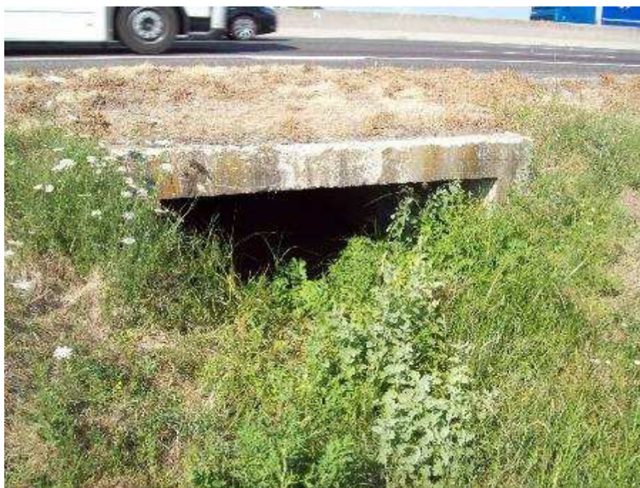
Figura 6-7. Fosso 12 in corrispondenza dello scatolare autostradale
