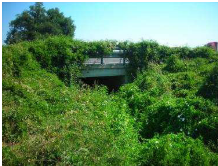
Figura 5-21. Rio Rosso in corrispondenza dello scatolare autostradale
