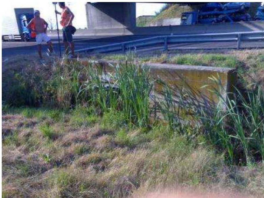
Figura 7-13. Fosso 36 in corrispondenza dello scatolare autostradale
