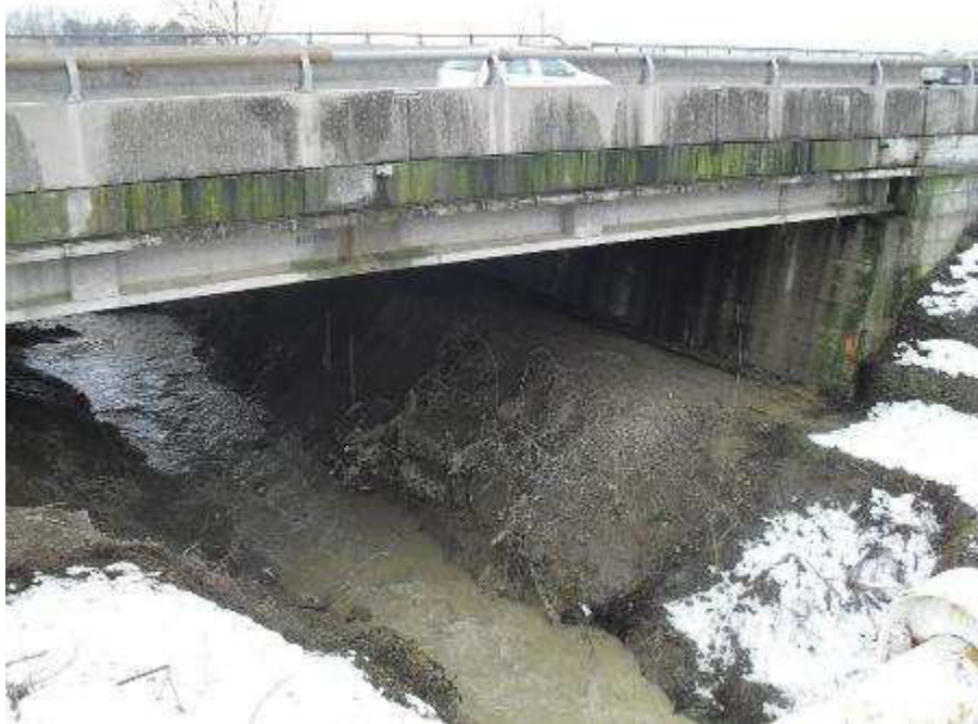
Figura 5-47. Rio Sanguinario in corrispondenza dell'attraversamento dell'autostrada A14
