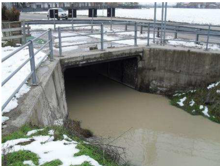
Figura 7-7. Scolo Molini in corrispondenza dello scatolare a valle dell'A14
