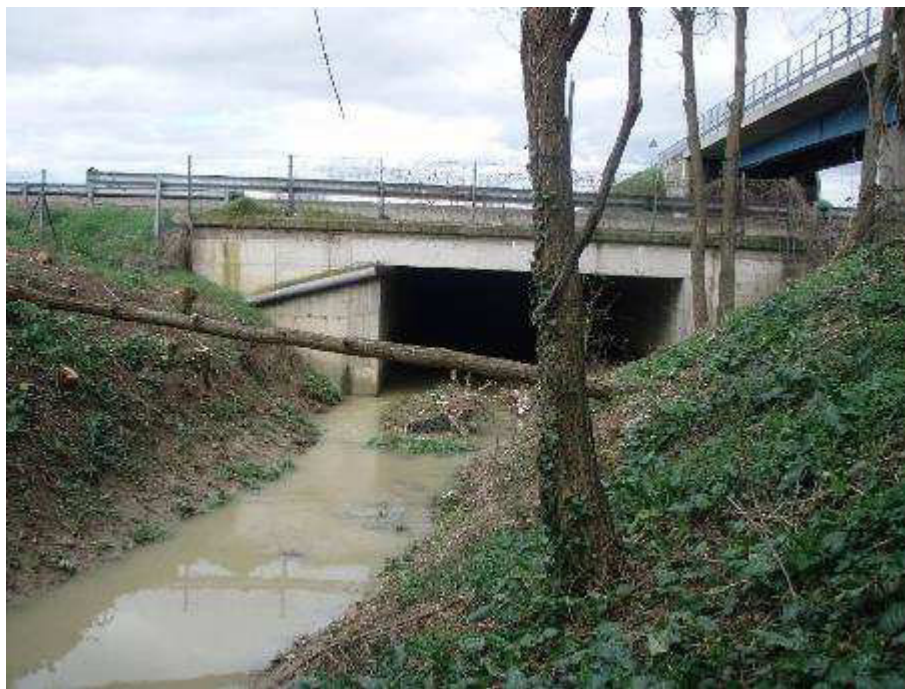
Figura 6-48. Scolo Consorziale Correcchio in corrispondenza dello scatolare autostradale
