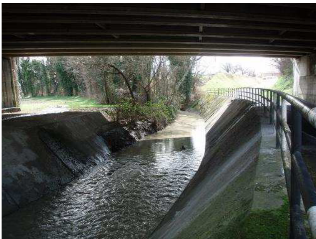
Figura 5-34. Torrente Sellustra in corrispondenza del ponte autostradale
