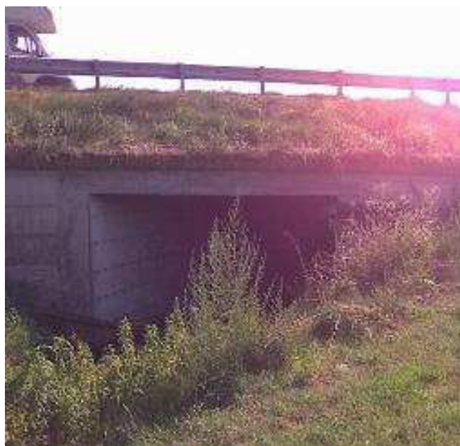
Figura 6-38. Scolo Consorziale Ladello in corrispondenza dello scatolare autostradale
