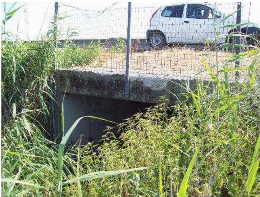
Figura 6-13. Fossa Grande in corrispondenza dello scatolare autostradale
