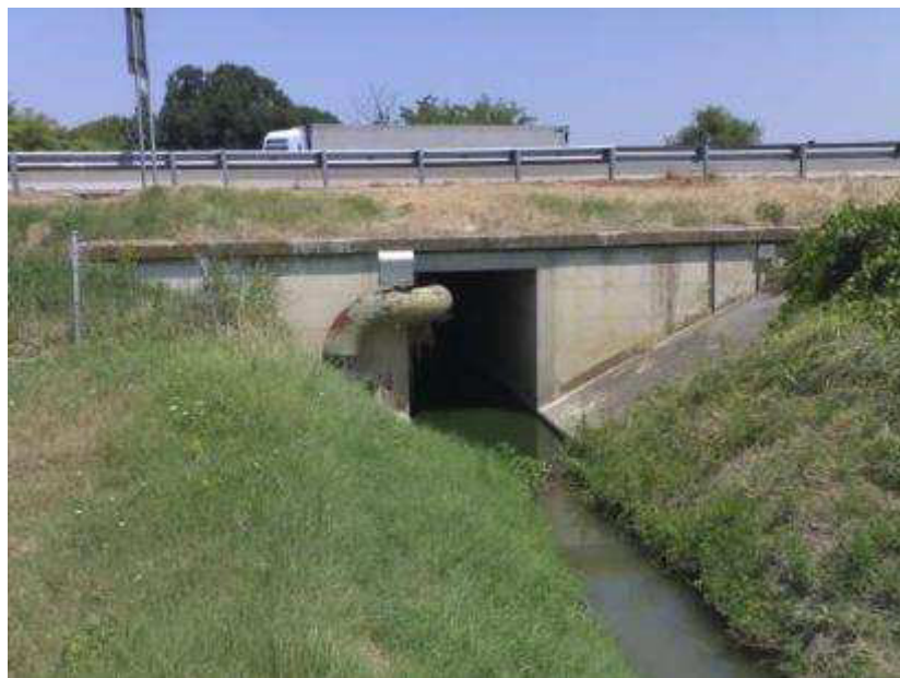
Figura 7-1. Scolo Correcchiello in corrispondenza dello scatolare autostradale
