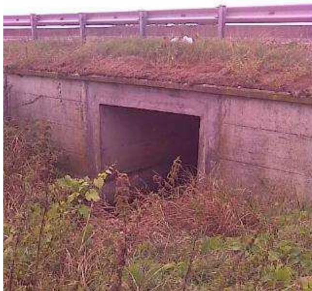
Figura 5-35. Scolo Fossatone in corrispondenza dello scatolare autostradale
