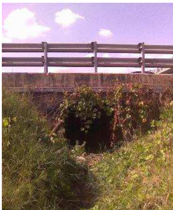
Figura 6-34. Fosso 28 in corrispondenza dello scatolare autostradale
