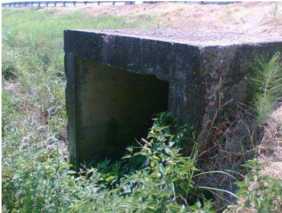
Figura 6-19. Fosso 17 in corrispondenza dello scatolare autostradale
