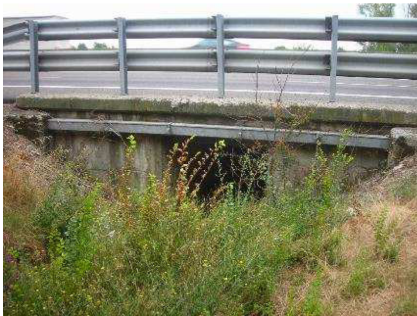
Figura 5-22. Rio Toscanella in corrispondenza dello scatolare autostradale
