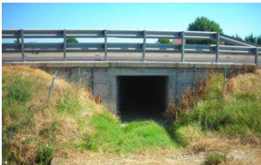
Figura 6-31. Fosso 27 in corrispondenza dello scatolare autostradale
