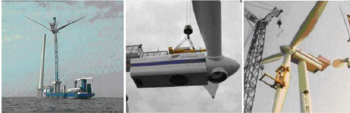
Installazione della turbina con il metodo bunny ear, nel progetto di Horns Rev.
