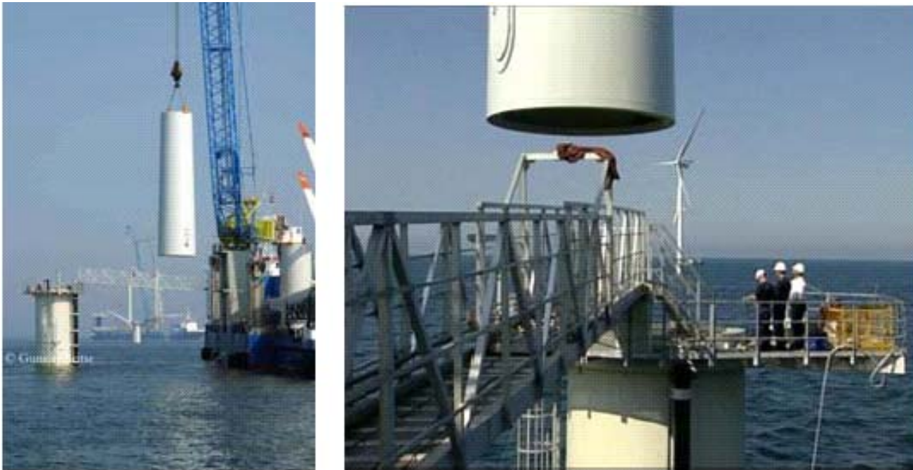
Installazione della torre in due componenti nel progetto di Horns Rev.
