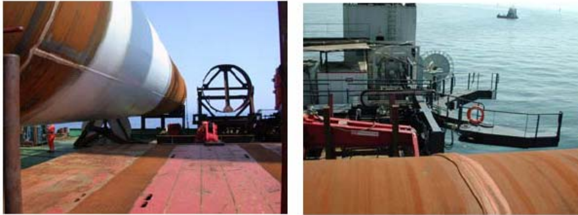
Tilting frame, dispositivo per inclinare i pali e portarli in posizione eretta; hammering frame, dispositivo per tenere i pali perfettamente verticali.
