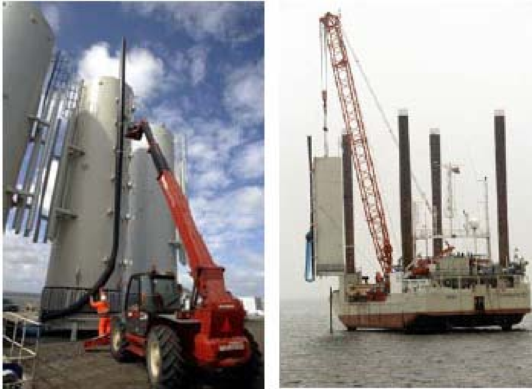
Installazione del pezzo di transizione nella centrale di Horns Rev in Danimarca
