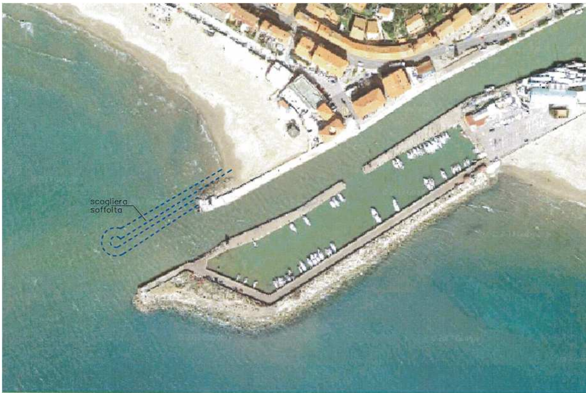
foto 7_vista area con indicazione dell'intervento
