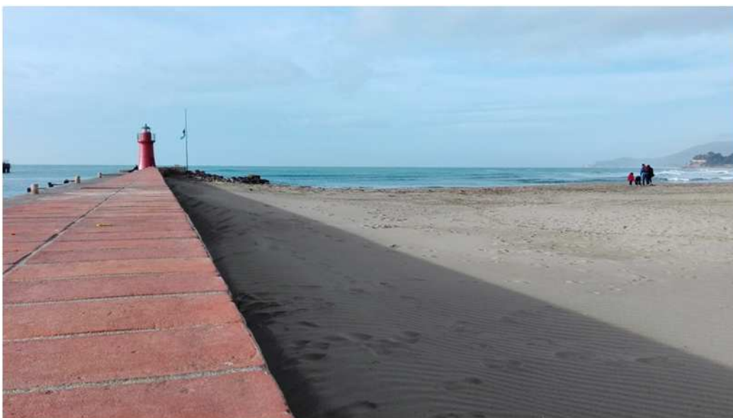
foto 4_vista in prospettiva dell'area adiacente al muro oggetto di passaggio mezzi di cantiere
