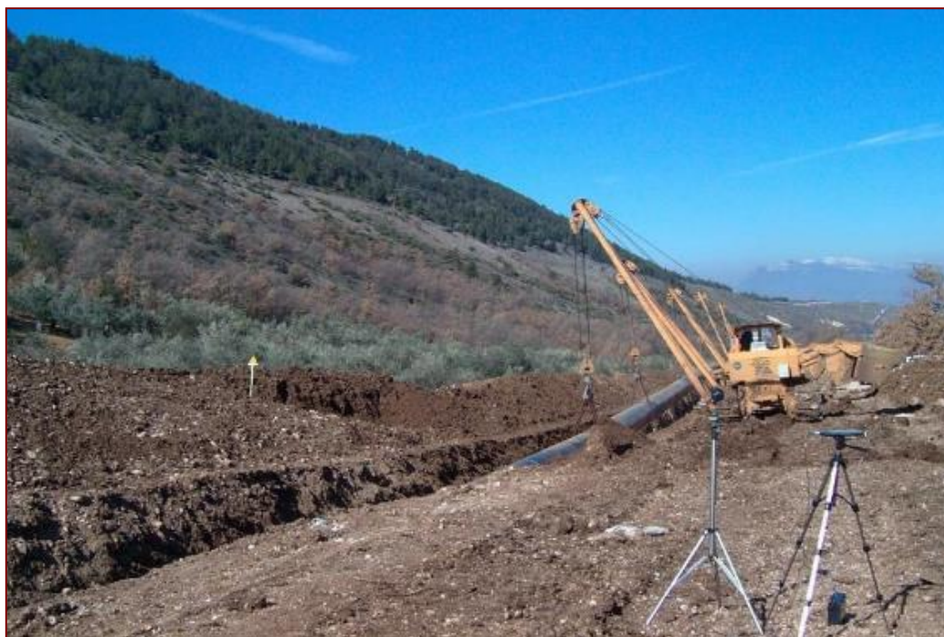
Figura 6-1 Rilievi acustici durante l'operazione di posa della condotta
