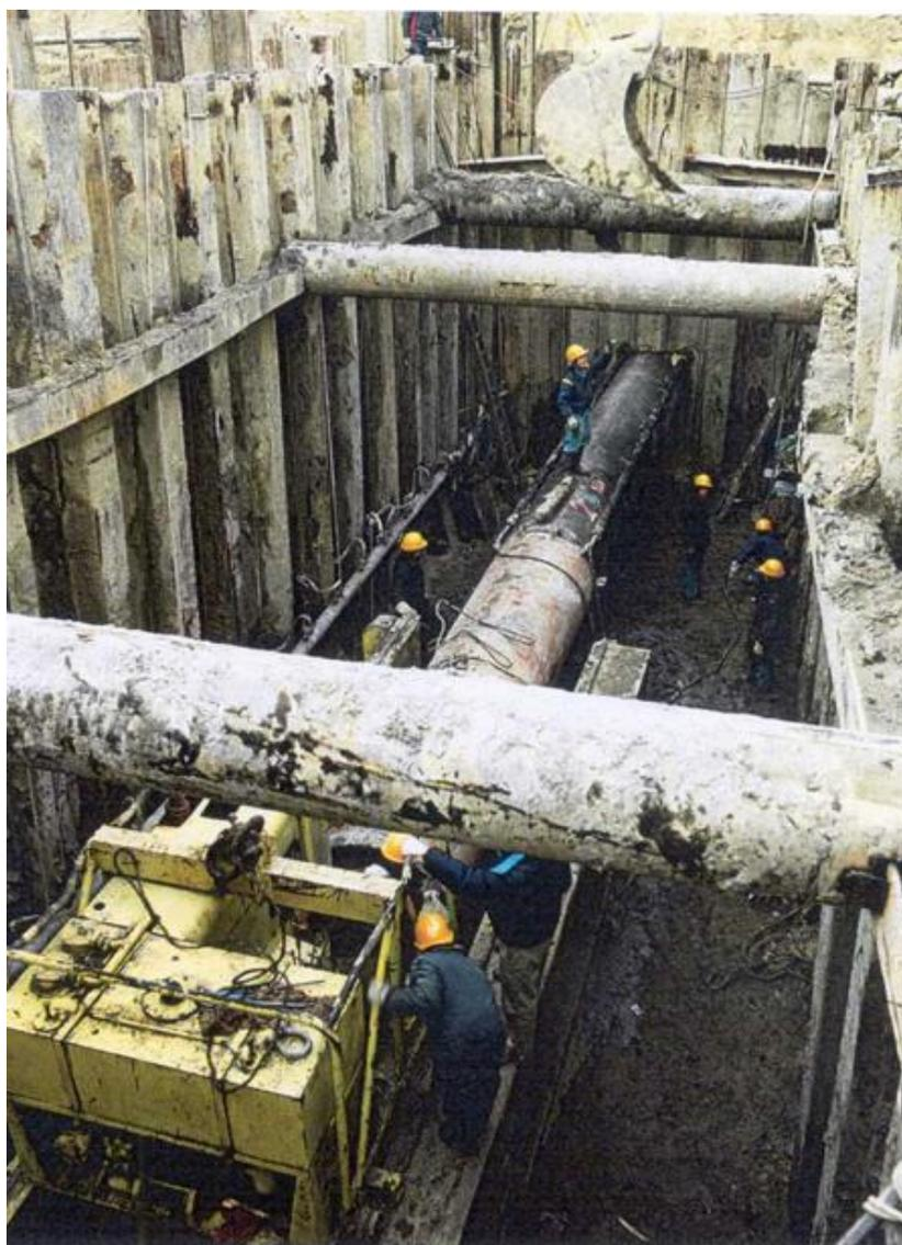
**Foto 5.1/J Trivellazione con spingitubo**
