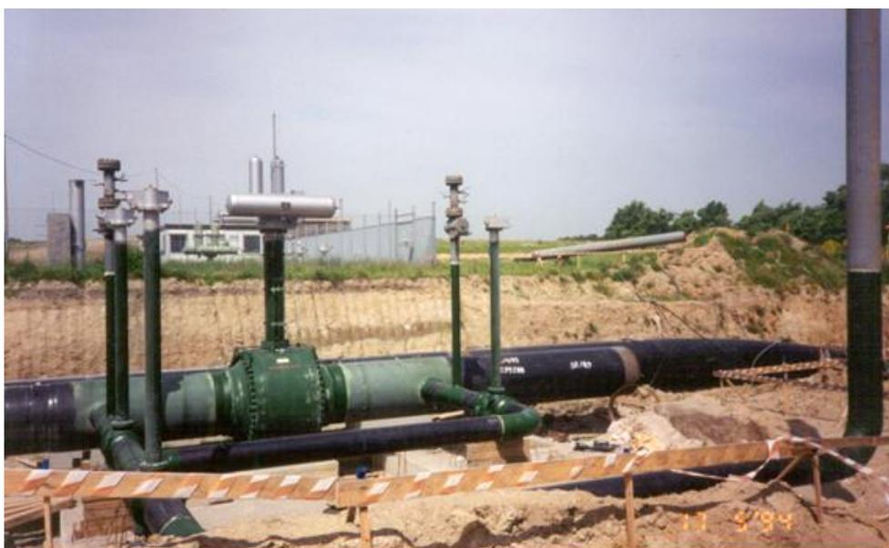
**Foto 5.1/L: Costruzione di un punto di intercettazione**
