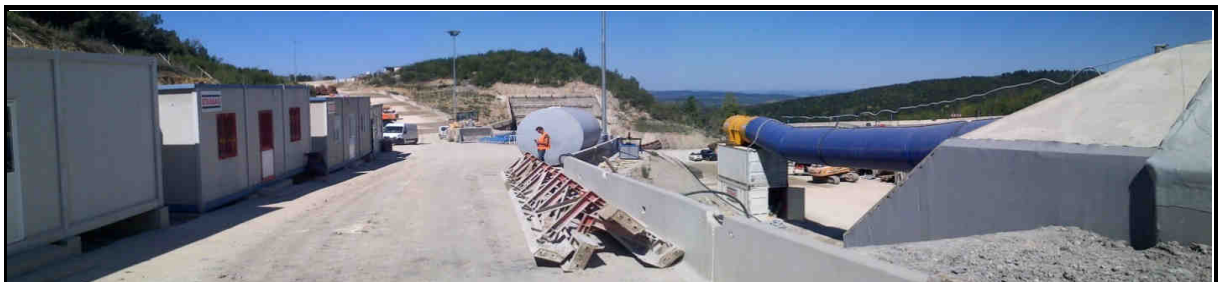
Foto panoramica - vista 3
