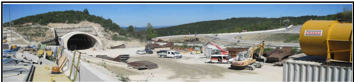
Foto panoramica - vista 4
