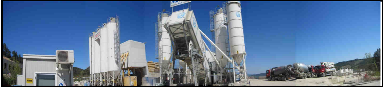
Foto panoramica - vista 1
