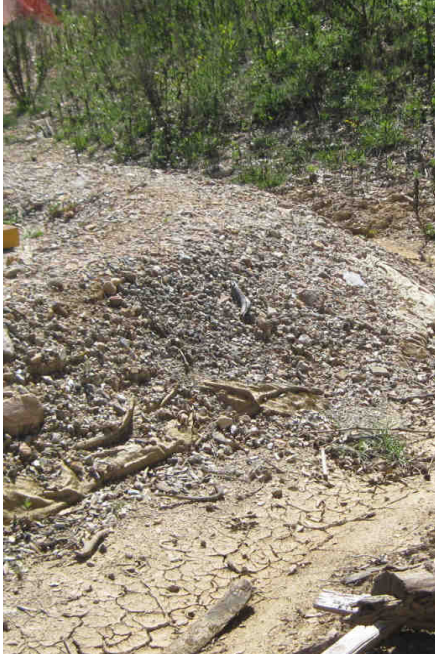
area impianto betonaggio
