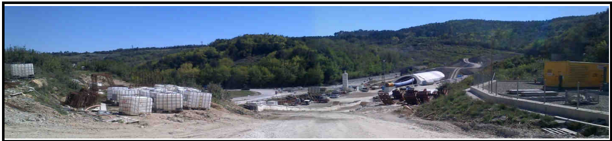
Foto panoramica - vista 2
