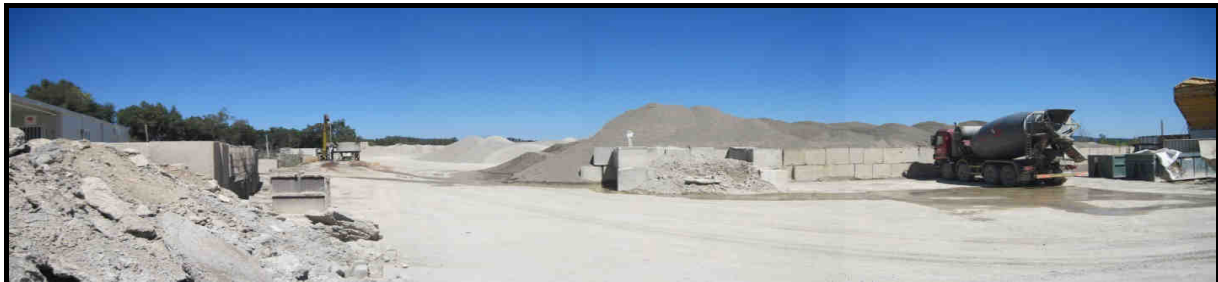
Foto panoramica - vista 2
