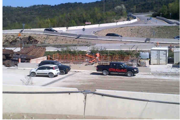
Campo operativo: deposito centine all'ingresso (a sinistra); impianto recupero acqua e fanghi (a destra)
