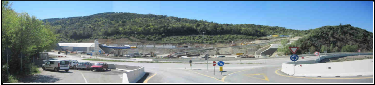
Foto panoramica - vista 1
