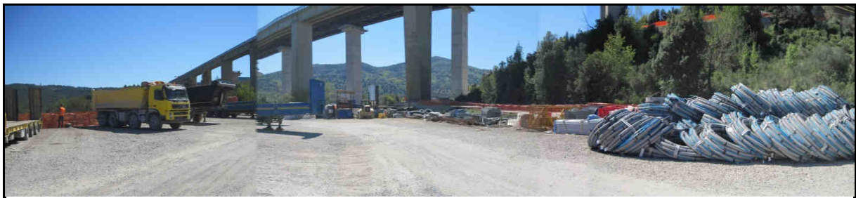
Foto panoramica - vista 4
