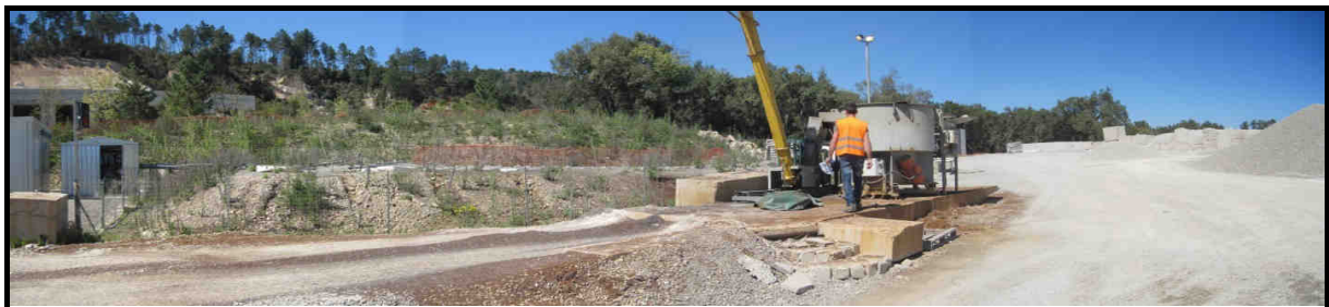
Foto panoramica - vista 3
