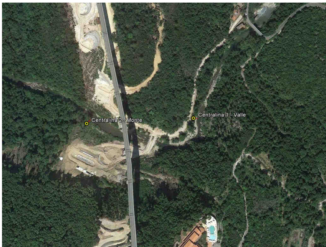
Figura 39 – Vista globale del sito di indagine
