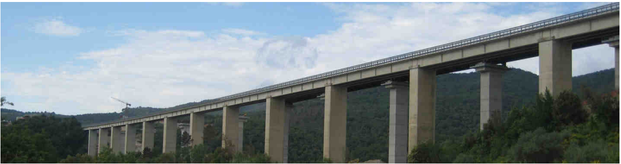
Figura 13 – Paesaggio PA07 / Viadotto Farma
