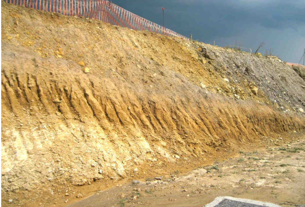
area campo operativo presso imbocco galleria
