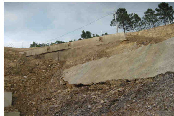
Pista (a sinistra); Dettaglio testa berlinese presso imbocco Galleria Poggio Terriccio (a destra)
