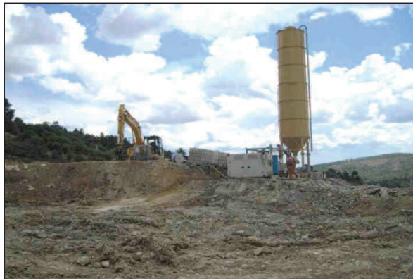
Impianto di iniezione: vista dell'impianto (a sinistra); stoccaggio (a destra)
