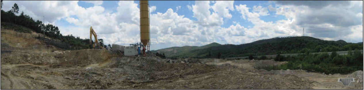
Figura 9 – Panoramiche SF 02 – Realizzazione berlinese imbocco galleria (in alto) e Campo operativo secondario (in basso)
