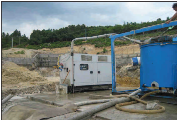
Impianto di iniezione: quadro elettrico con base in calcestruzzo (a sinistra); silos con base in calcestruzzo (a destra)
