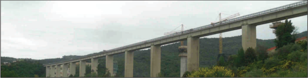
Figura 13 – Paesaggio PA07 / Viadotto Farma
