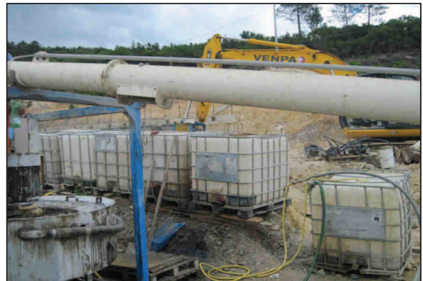
Impianto di iniezione: vista dell'impianto (a sinistra); stoccaggio (a destra)
