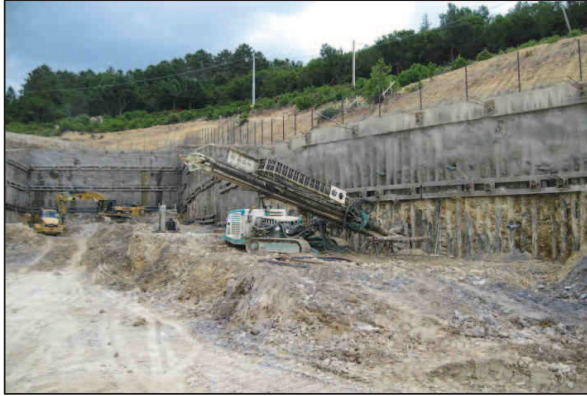
Lavorazioni sulla berlinese (sinistra); piazzale, pista di cantiere e cumuli (a destra)
